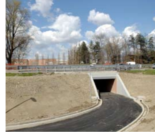
sottopasso ciclopedonale Nuova Estense
