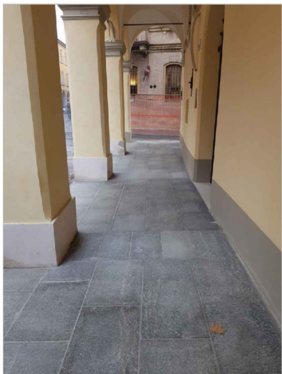
Realizzazione di marciapiede in Pietra Luserna Grigia con posa sfalsata, a correre
