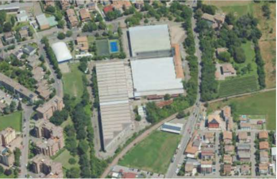
Vista obliqua stato di fatto da via Giardini
