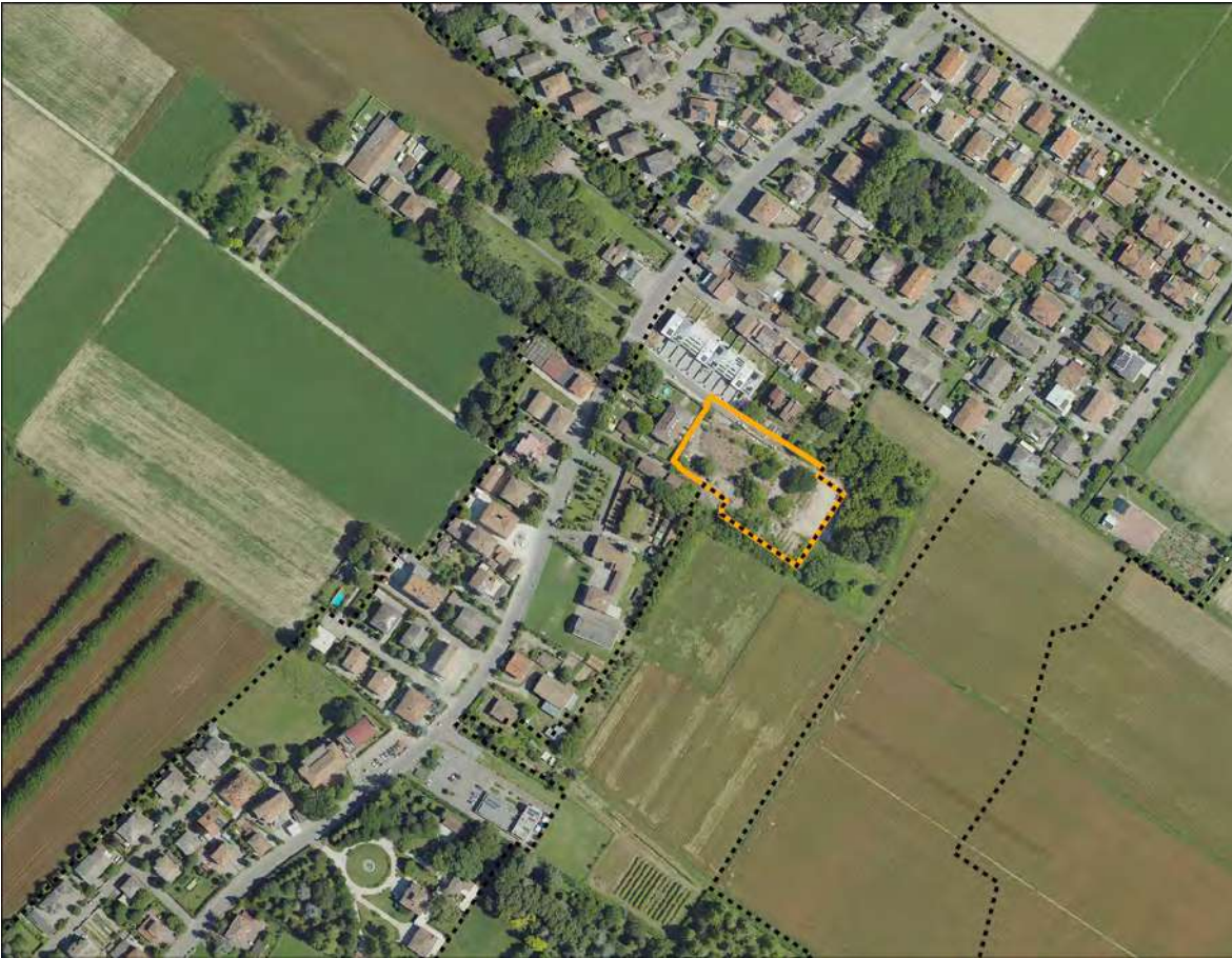
Ortofoto stato di fatto
