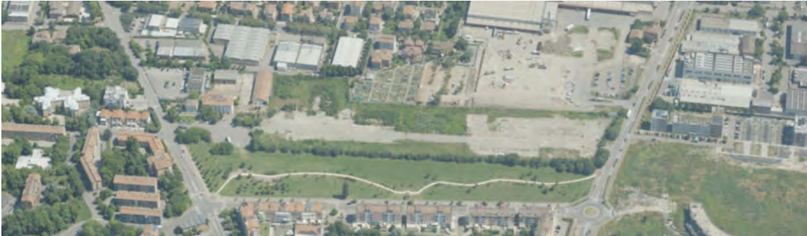
Vista obliqua stato di fatto da sud
