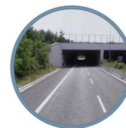
Vizzola Ticino (VA). Ecodotto sulle SS336 e SP 52. L'ecodotto consente il passaggio antropico e della fauna, rappresenta la soluzione migliore per la mitigazione degli impatti delle infrastrutture sulla biodiversità.
