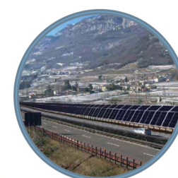
Autostrada del Brennero. Celle fotovoltaiche integrate con i supporti per la mitigazione acustica.
