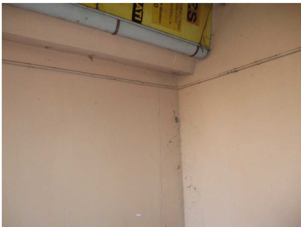
Figura 33: Foto esterne – Fabbricato n°3 Assenza di ammorsamento murario.
