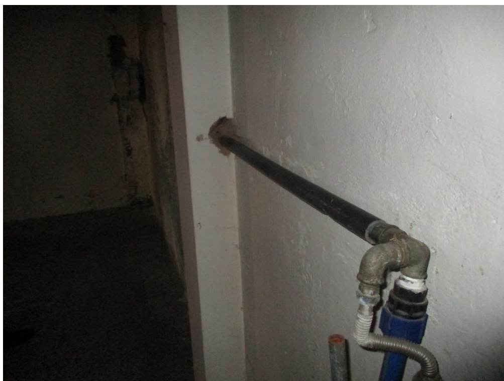
Figura 14: Foto interne – Fabbricato n°1. Grave danneggiamento del Pilastro in muratura per passaggio degli impianti.
