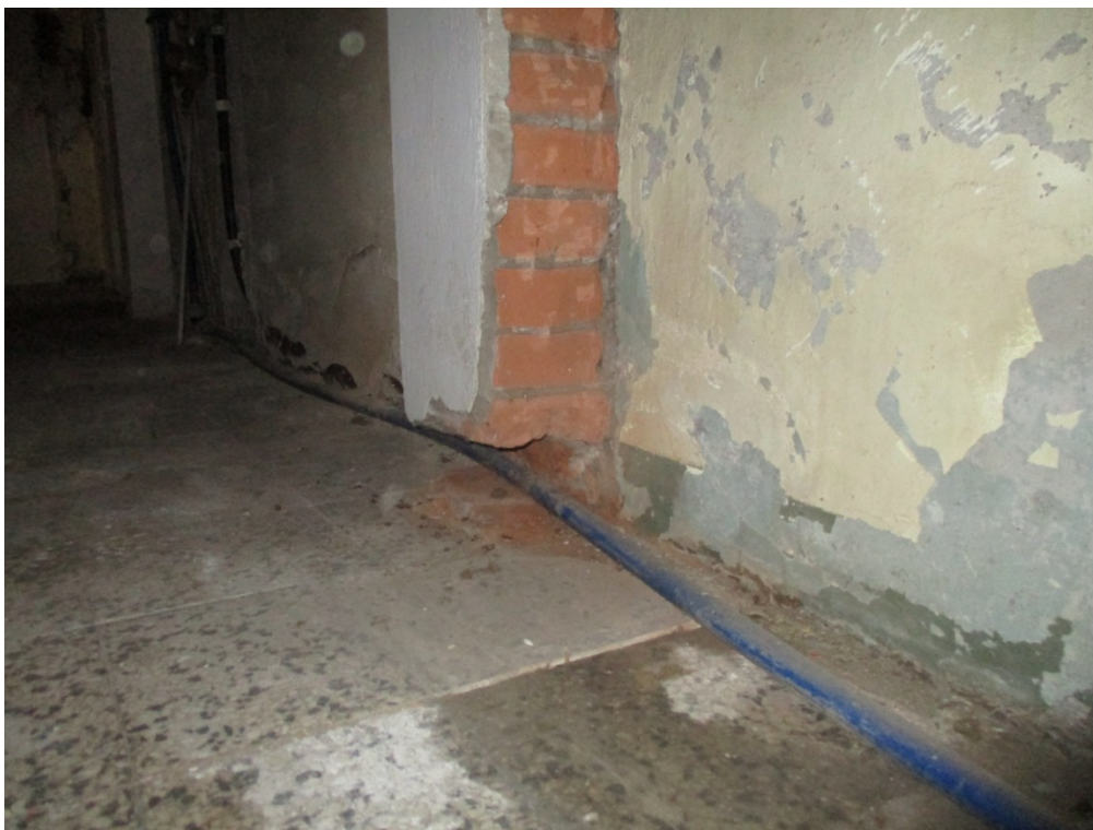
Figura 13: Foto interne – Fabbricato n°1. Grave danneggiamento del Pilastro in muratura per passaggio degli impianti.
