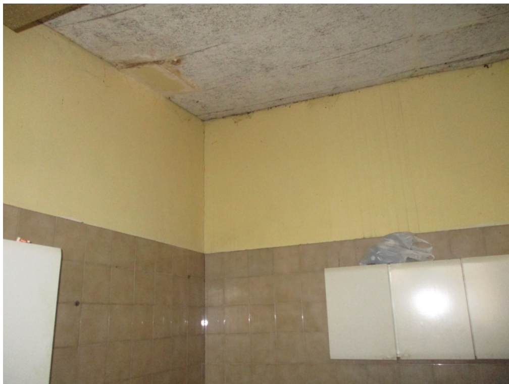
Figura 42: Foto interne – Fabbricato n°4. Assenza di ammorsamento murario.
