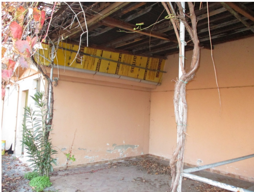
Figura 32: Foto esterne – Fabbricato n°3 Assenza di ammorsamento murario.
