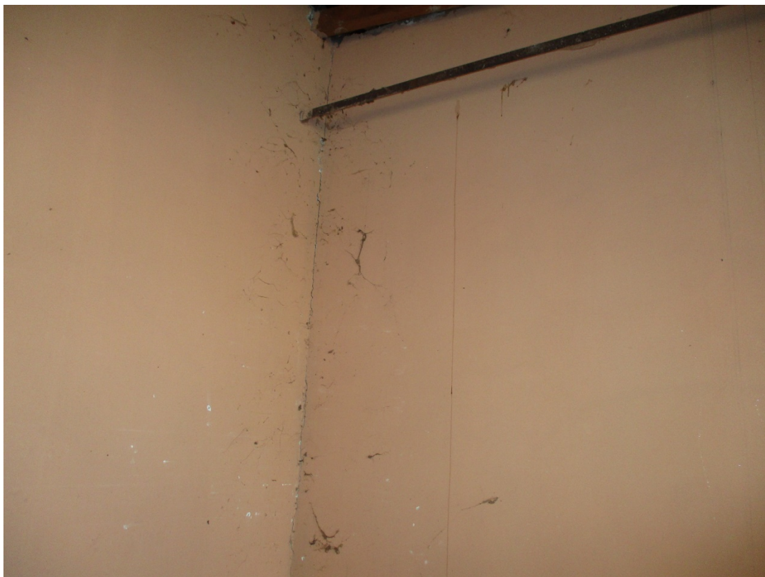
Figura 43: Foto esterne – Fabbricato n°4 Assenza di ammorsamento murario.
