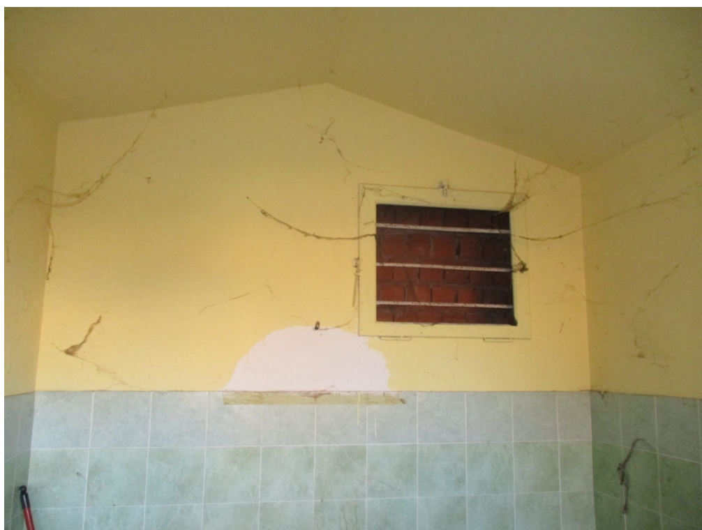
Figura 35: Foto interne – Fabbricato n°3 Assenza di ammorsamento murario.
