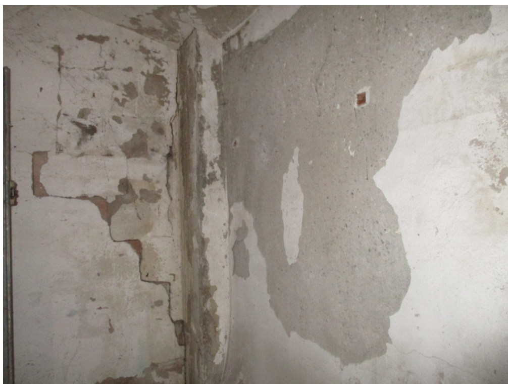
Figura 39: Foto esterne – Fabbricato n°3 Gravi lesioni sismiche orizzontali e a 45°.
