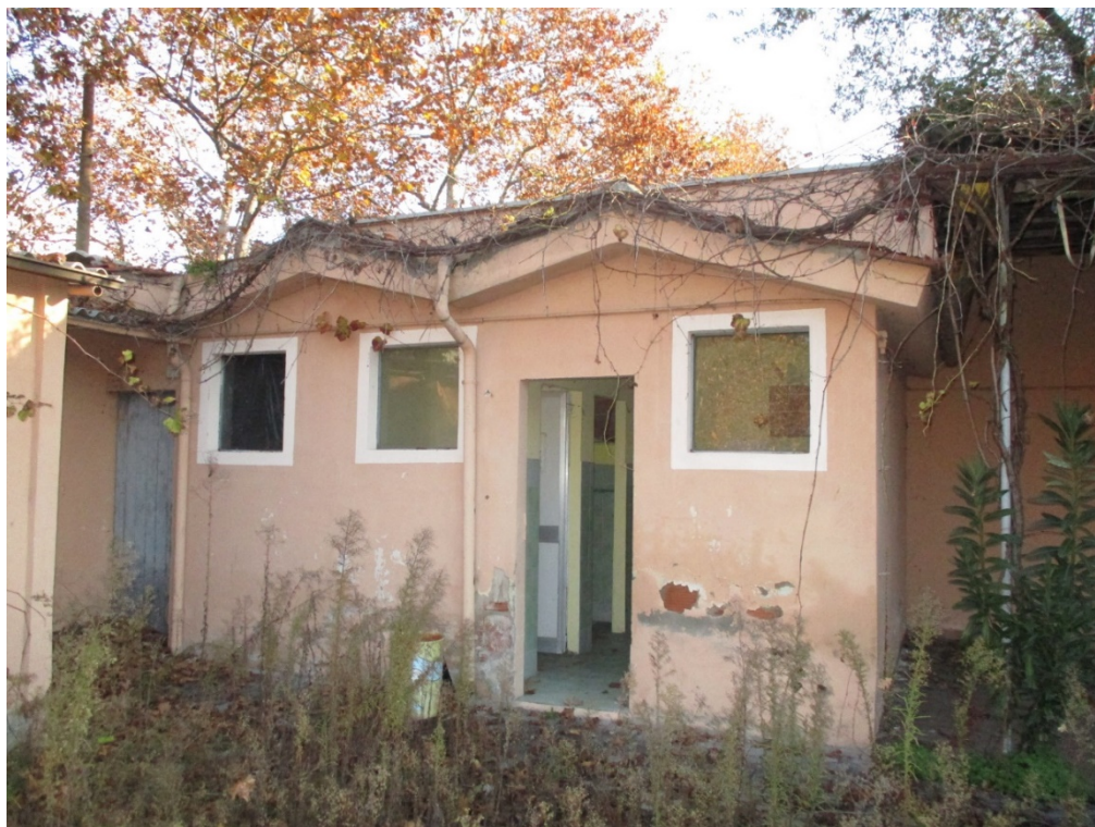
Figura 34: Foto esterne – Fabbricato n°3 Assenza di ammorsamento murario.
