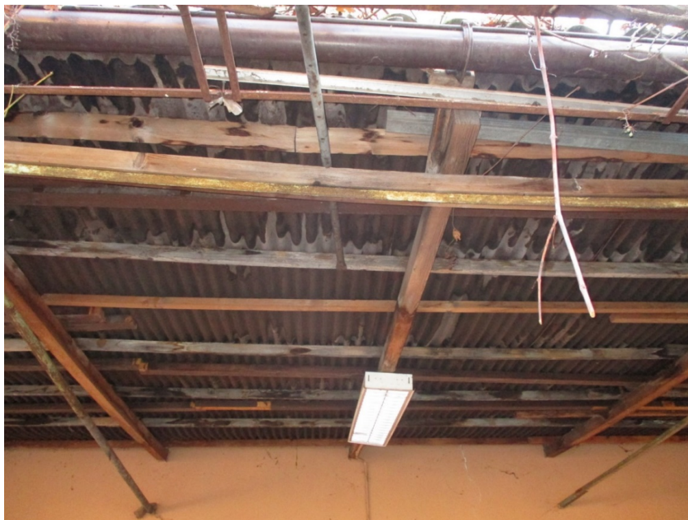
Figura 31: Foto esterne – Fabbricato n°3. La copertura nella zona centrale risulta fortemente pericolante.
