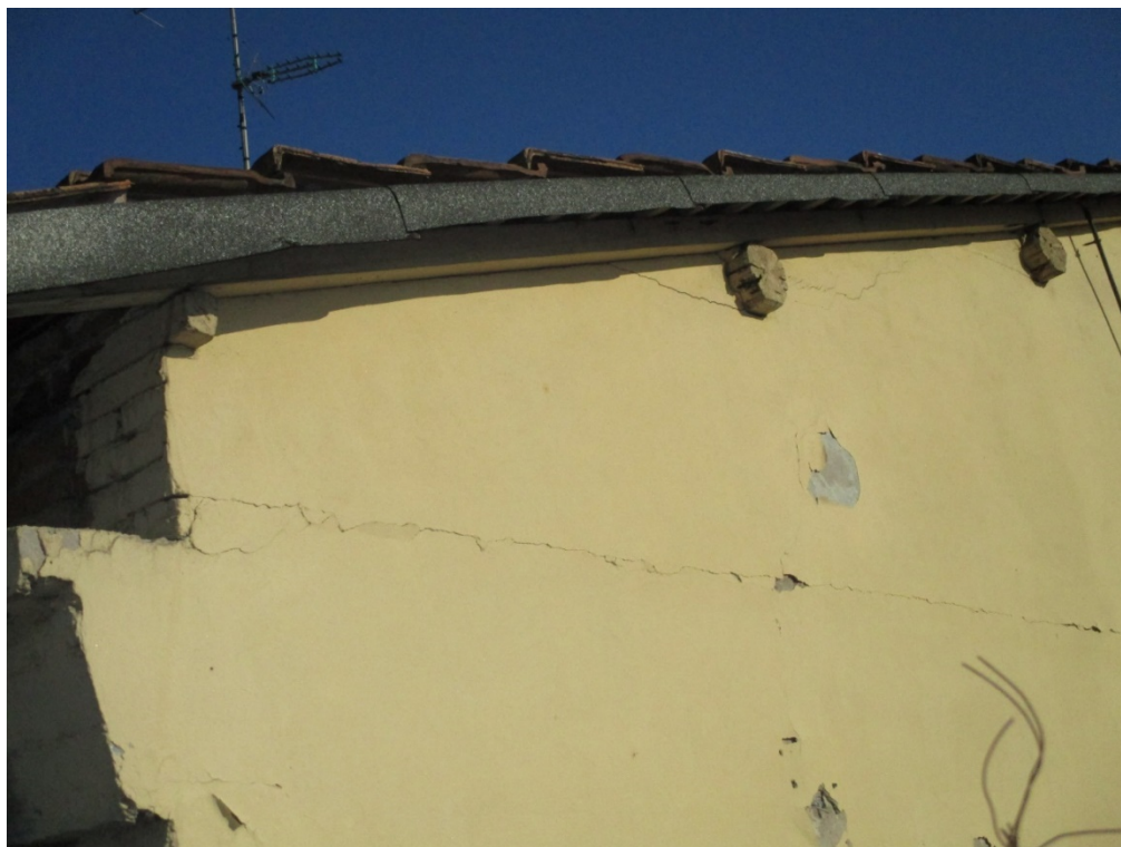
Figura 7: Foto dall'esterno – Fabbricato n°1. Evidente Lesione orizzontale in corrispondenza del collegamento fra il solaio e il timpano in muratura.
