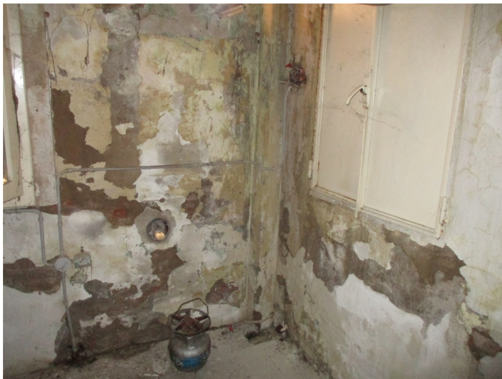
Figura 11: Foto interne – Fabbricato n°1. Distacco dell'intonaco dovuto a problemi di umidità.
