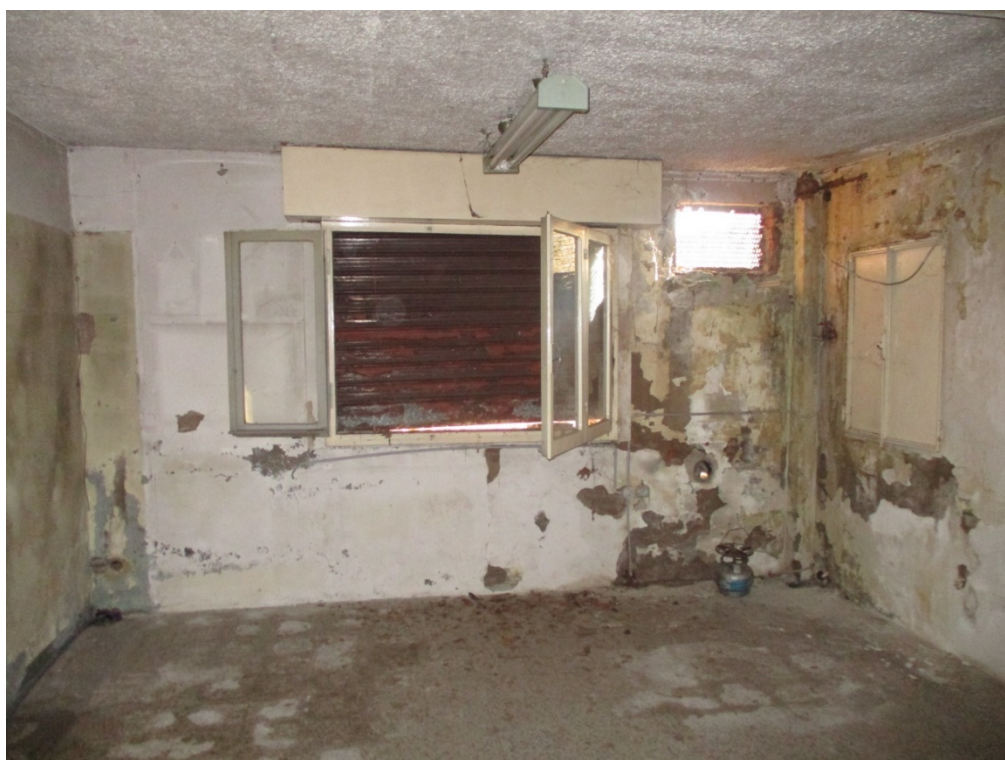
Figura 10: Foto interne – Fabbricato n°1. Distacco dell'intonaco dovuto a problemi di umidità.
