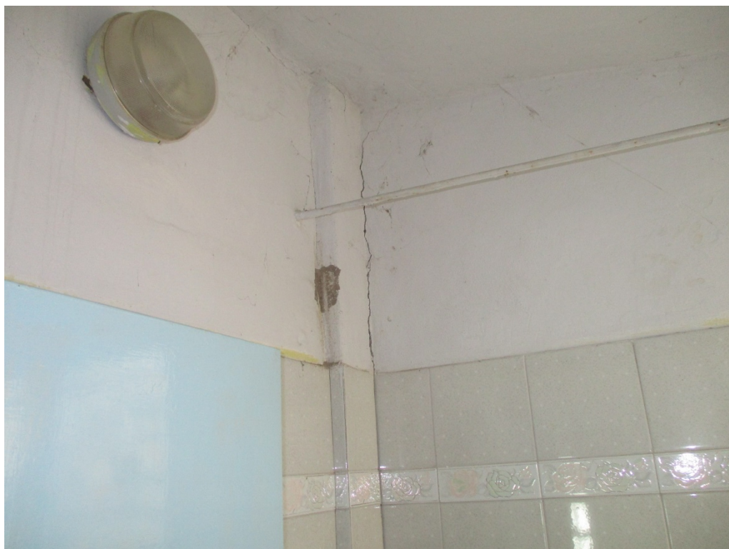
Figura 18: Foto interne – Fabbricato n°1. Mancato ammorsamento fra la struttura principale in calcestruzzo armato e strutture in muratura costruite successivamente.
