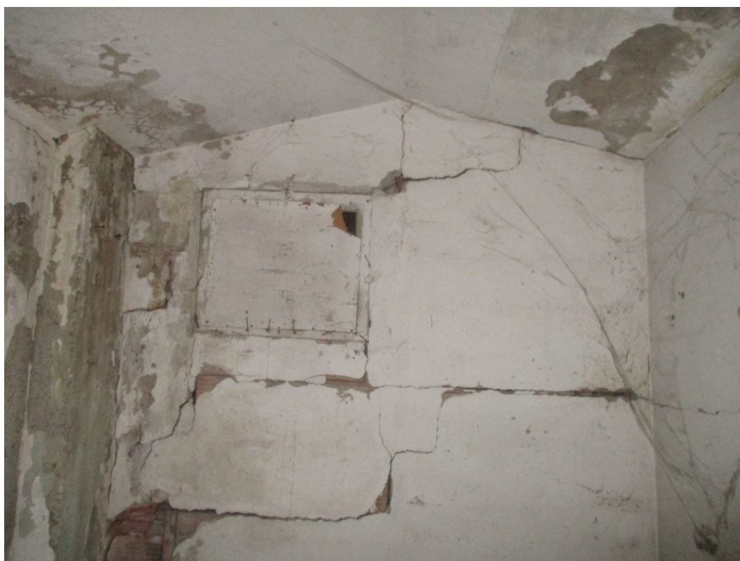
Figura 37: Foto esterne – Fabbricato n°3 Gravi lesioni sismiche orizzontali e a 45°.
