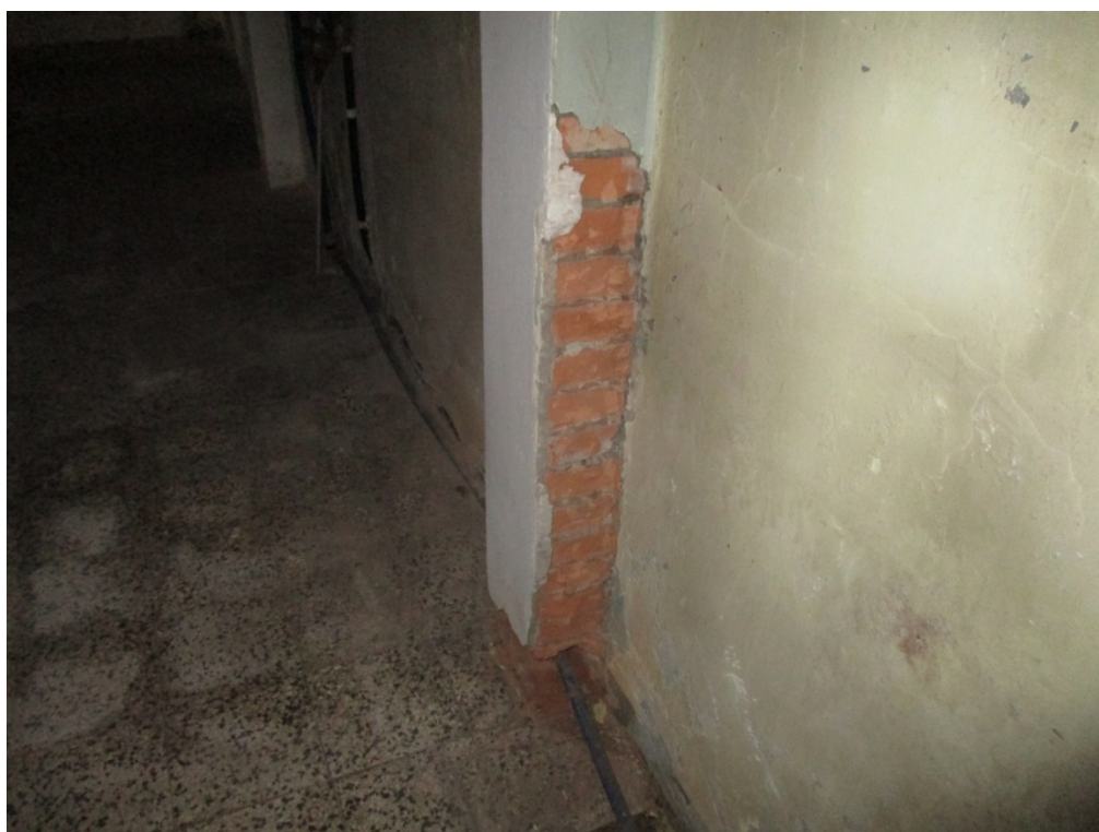
Figura 12: Foto interne – Fabbricato n°1. Grave danneggiamento del Pilastro in muratura per passaggio degli impianti.
