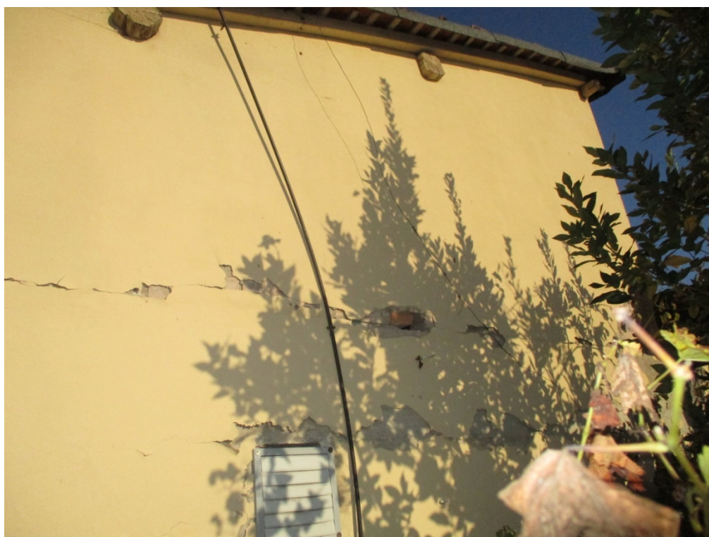
Figura 8: Foto dall'esterno – Fabbricato n°1. Evidente Lesione orizzontale in corrispondenza del collegamento fra il solaio e il timpano in muratura.
