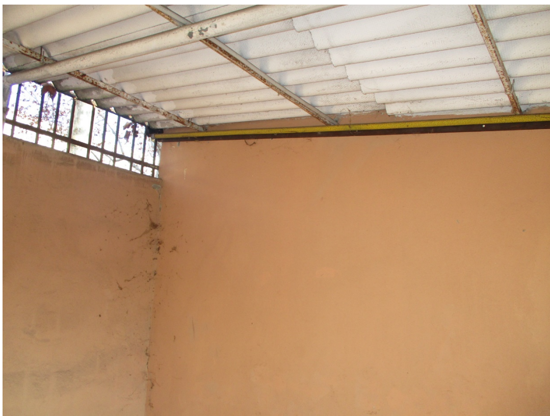
Figura 26: Foto esterne – Fabbricato n°2 Probabile assenza di ammorsamento murario.
