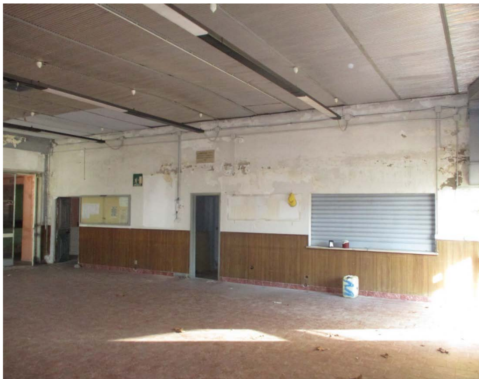
Figura 9: Foto interne – Fabbricato n°1. Distacco dell'intonaco dovuto a problemi di umidità.
