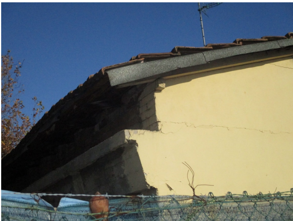
Figura 6: Foto dall'esterno – Fabbricato n°1. Evidente Lesione orizzontale in corrispondenza del collegamento fra il solaio e il timpano in muratura.
