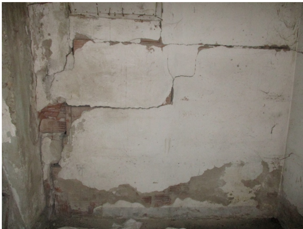
Figura 38: Foto esterne – Fabbricato n°3 Gravi lesioni sismiche orizzontali e a 45°.
