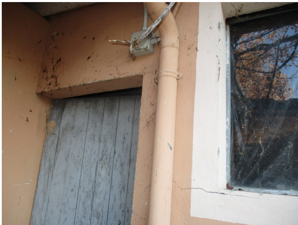
Figura 36: Foto esterne – Fabbricato n°3 Gravi lesioni sismiche orizzontali e a 45°.
