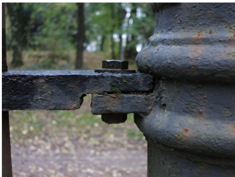
Foto 2 – Fissaggio della grata alla colonna.
