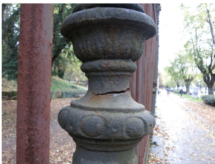
Foto 8 – Dettaglio della colonna in ghisa spezzata.
