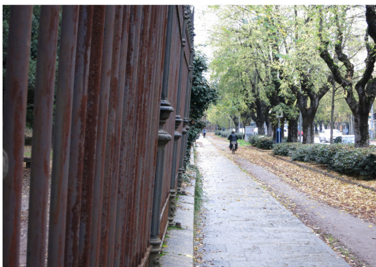
Foto 4 – La recinzione sud: l'inclinazione massima è di circa 5 gradi.
