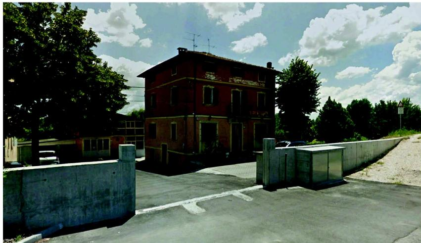
Figura 2-8 – Dettaglio del fiume Panaro a Navicello: si evidenzia il muro recentemente realizzato e il varco per l'accesso ad abitazioni poste in golenia, che viene chiuso in condizioni di piena.
