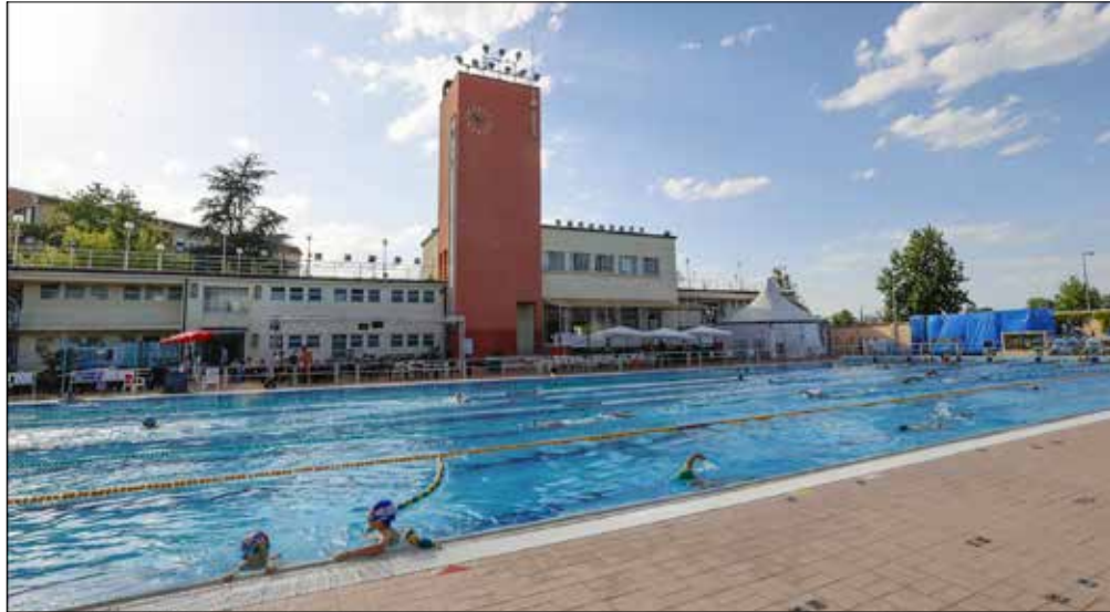
In foto, le piscine Dogali interessate da interventi di manutenzione straordinaria (circa 62mila euro). In basso, un dettaglio del nido d'infanzia Gambero della Fondazione Cresci@mo
