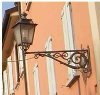
Lanterna artistica a mensola con lampada ai vapori di sodio
