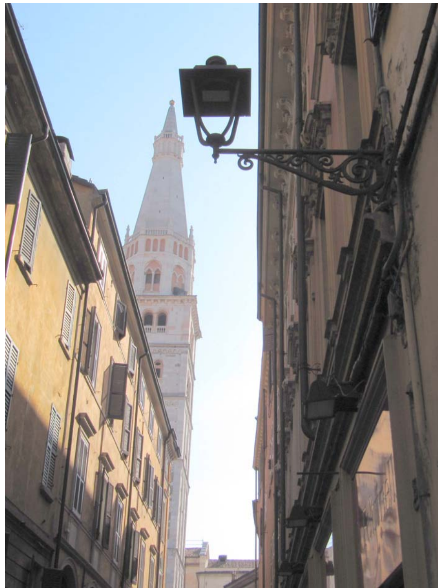
21/03/2012. Particolare della nuova lampada con lampadina LED.
