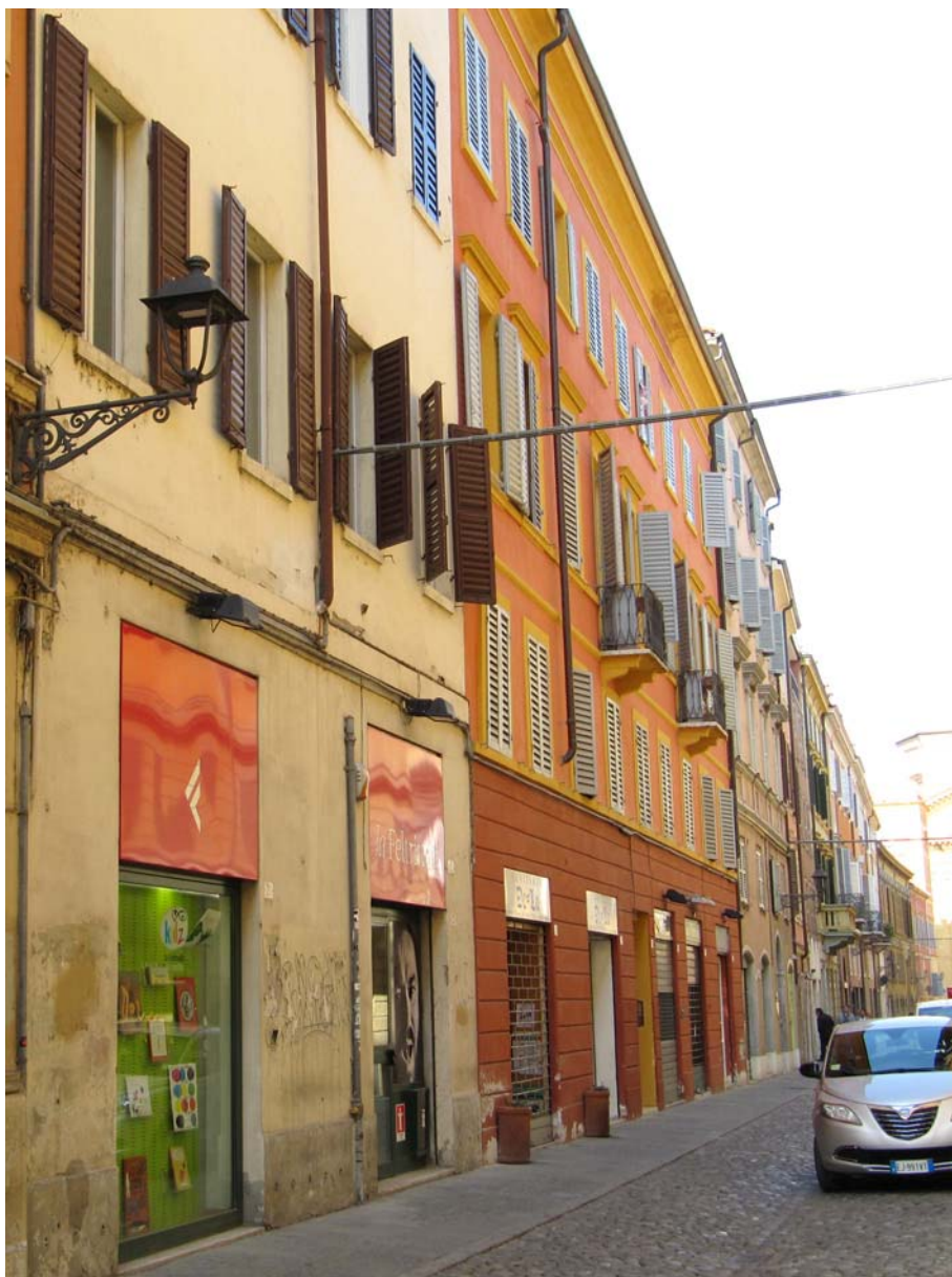
21/03/2012. Visuale in direzione di Via Taglio, dopo la sostituzione del corpo illuminante per poter alloggiare la nuova lampadina LED.
