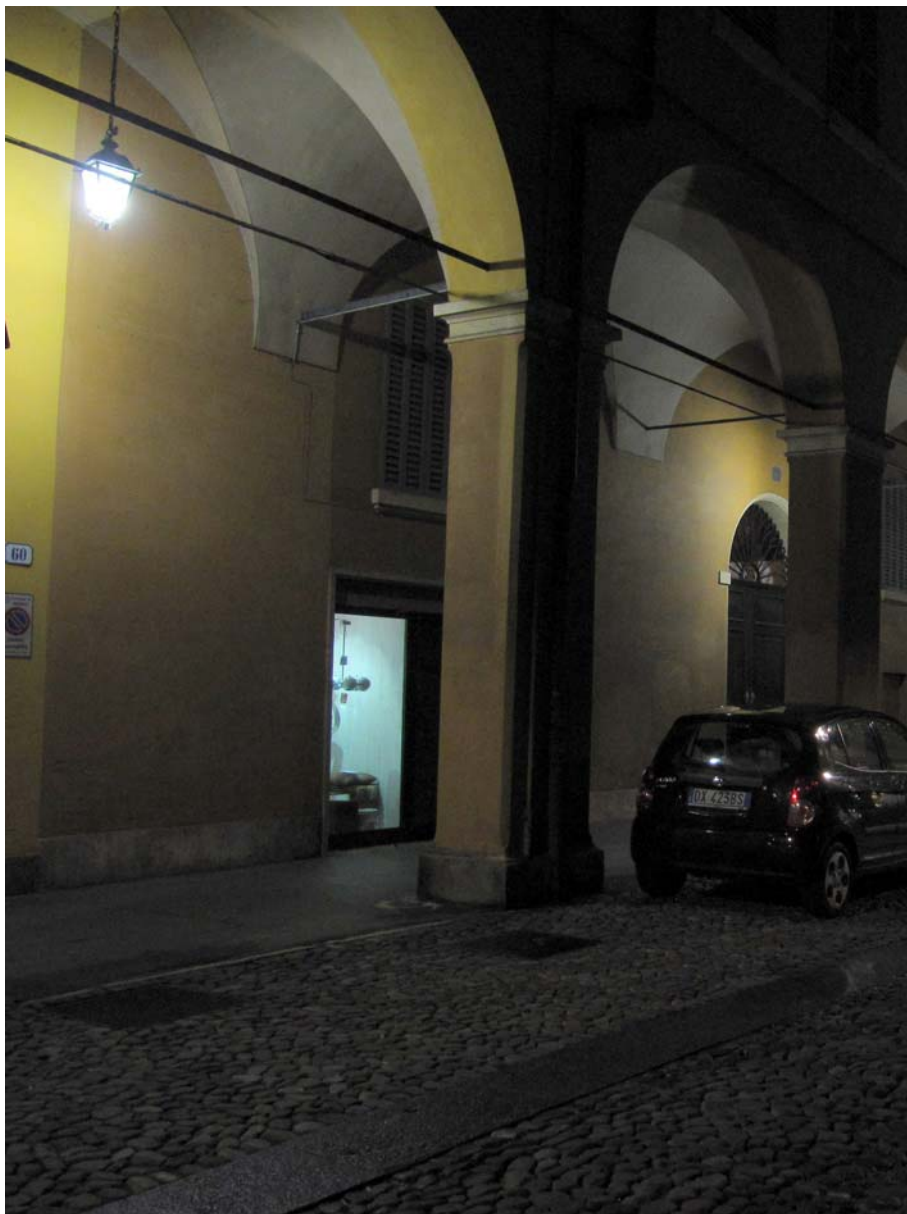
16/04/2012. Particolare del portico di Via Battisti, con la nuova lampada con lampadina LED.
