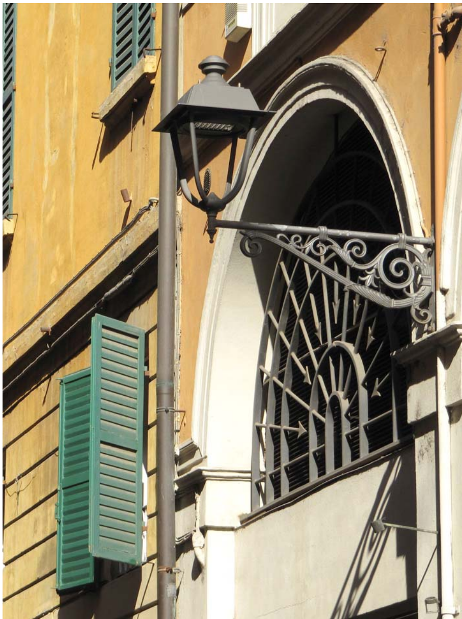
21/03/2012. Particolare della nuova lampada con lampadina LED.
