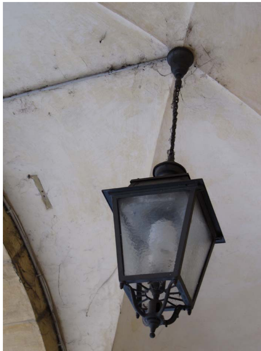
16/01/2012. Particolare della lampada in cui si nota l'uso del vetro "cattedrale" non perfettamente liscio, ma trasparente.
