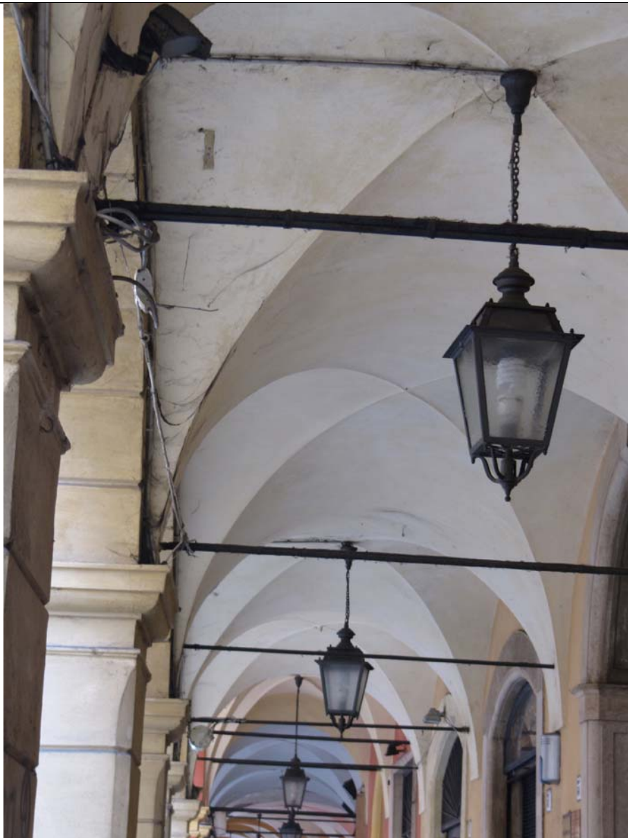
16/01/2012. Particolare delle lanterne tradizionali in cui sono state sostituite le lampadine ai vapori di sodio, con lampadine LED .
