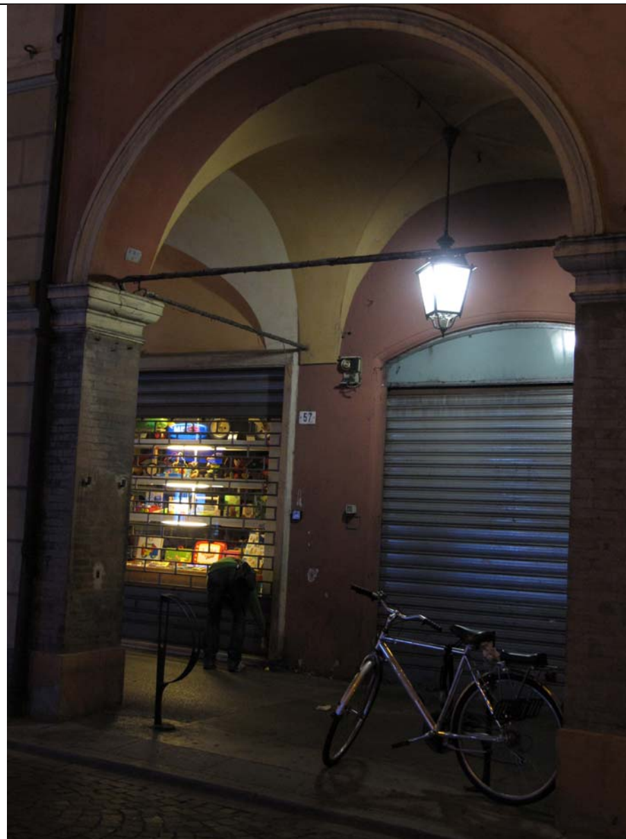
19/09/2011. Un'arcata del portico, in prossimità di Largo San Giorgio, illuminata con lampadina a LED inserita nella lanterna tradizionale.
