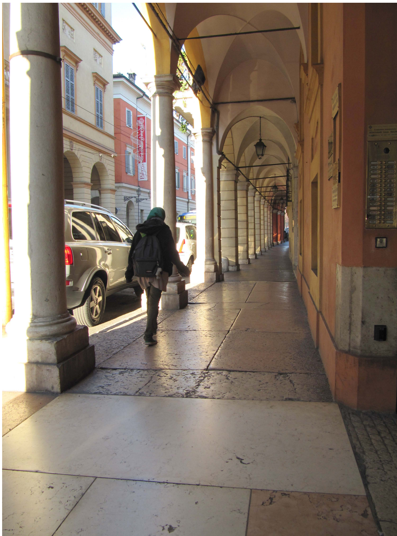
Portico del Palazzo Caroli Cesis del sec. XVIII, in Corso Canalgrande. Confronto fra lastre antiche, usurate e nuove lastre.
