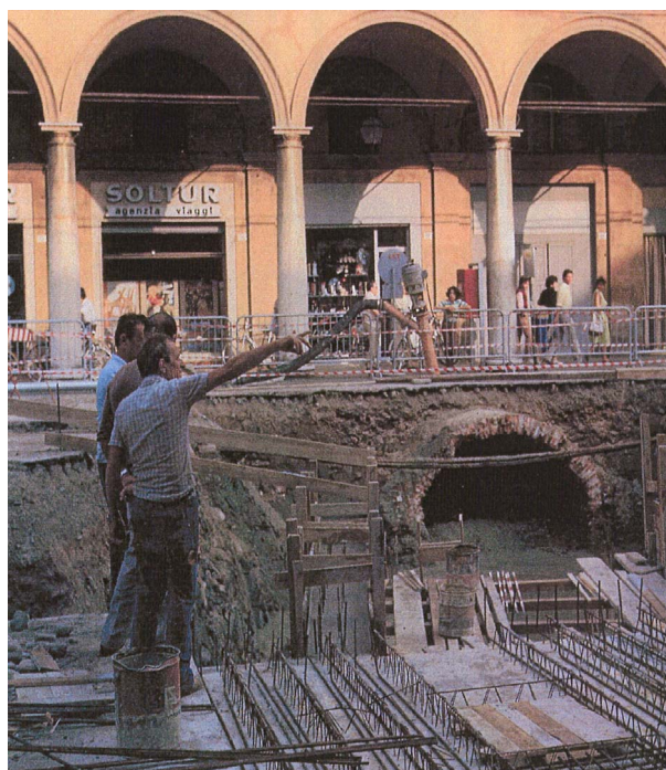
Lavori al Canale S. Pietro in Largo San Giorgio (1984)
