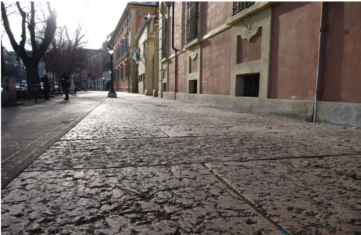
Particolare della "superficie scabra" delle lastre, posate con ampie fughe .
