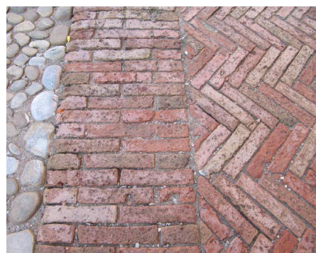
LATO NORD DELLA CHIESA - L'AMMATTONATO TRADIZIONALE: CON DUE TIPI DI POSA E L'ACCOSTAMENTO AL SELCIATO IN ACCIOTTOLATO
