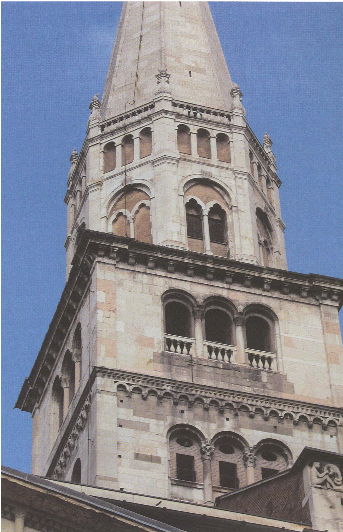
Le parti sommitali della torre Ghirlandina: a partire dal 6° piano, sono state rivestite utilizzando un unico tipo di roccia, il Rosso Ammonitico veronese in lastre di nuova cavatura.
