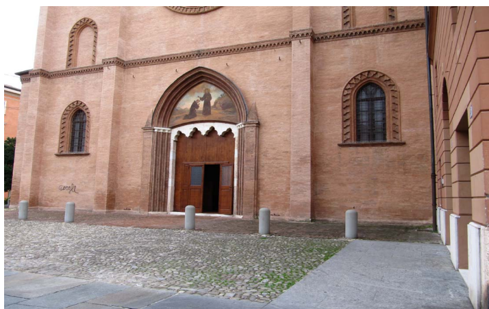
IL SAGRATO ALL'INGRESSO DELLA CHIESA SELCIATURA MISTA: ACCIOTTOLATO ED AMMATTONATO
