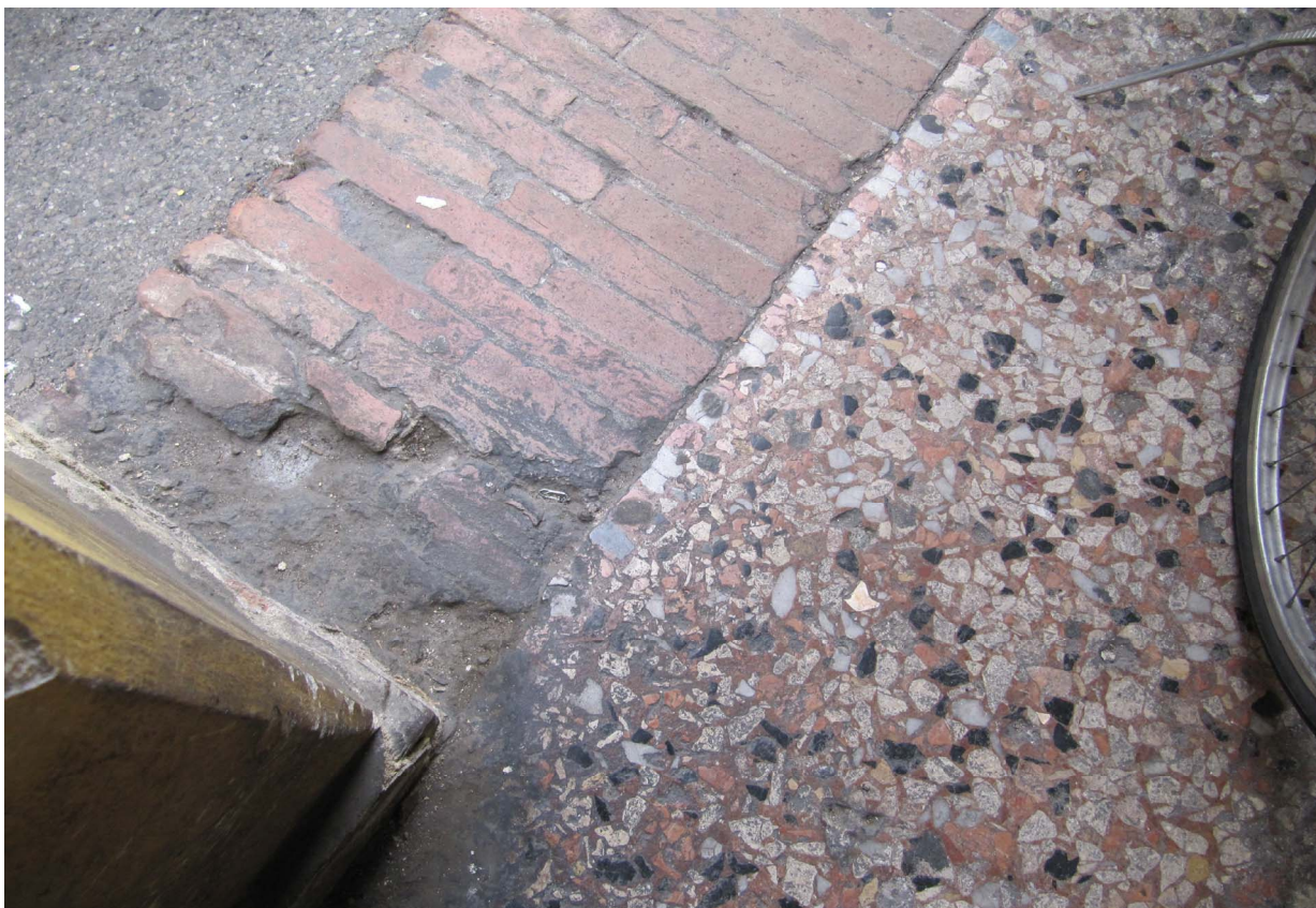
PARTICOLARE 10 - PORTICO DI CORSO CANALGRANDE TRATTO COMPRESO FRA VIA DELLE CARMELITANE SCALZE E VIA S. GIOVANNI DEL CANTONE
