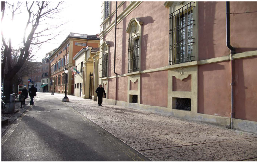
Corso Vittorio Emanuele II nel 2011. Particolare della lastricatura di uno degli due ampi marciapiedi laterali: si tratta di lastre di grandi dimensioni e di notevole spessore, in "ammonitico veronese o marmo rosa di Verona" .
