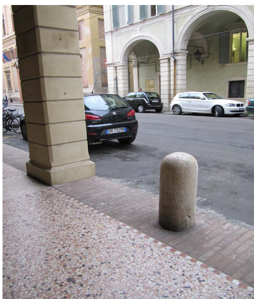
PARTICOLARE 9 - PORTICO DI CORSO CANALGRANDE ( ORA RISTRUTTURATO ) TRATTO COMPRESO FRA VIA DELLE CARMELITANE SCALZE E VIA S. GIOVANNI DEL CANTONE Si noti l'inserimento dei fittoni in marmo di Verona all'interno dell'ammattionato fra i pilastri del portico.
