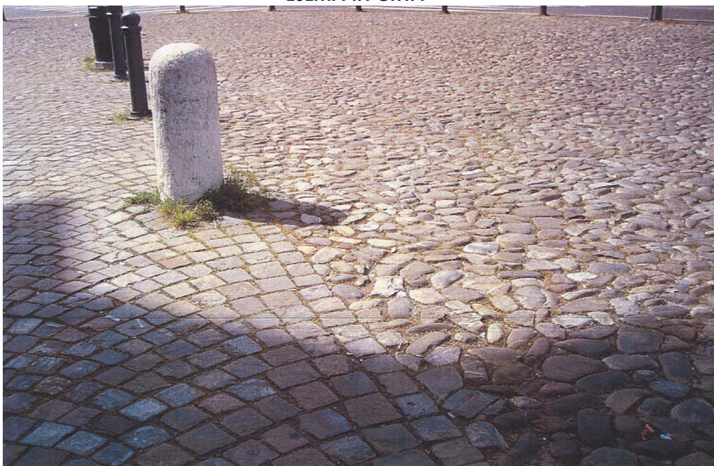
PARTICOLARE 1 – INGRESSO DELLA SALA MOSTRE PRESSO IL “FORO BOARIO” (LATO SUD DELL'EDIFICIO, RISTRUTTURATO) IL LASTRICATO E' REALIZZATO CON CUBETTI DI SELCE, AL FINE DI OTTENERE UN ISOLA PEDONALE ANTISTANTE L'INGRESSO DEL PARCHEGGIO PUBBLICO NOVI SAD (AREA DELL'EX IPPODROMO). I CUBETTI QUADRATI DI SELCE SONO STATI AFFIANCATI DA CIOTTOLI.
