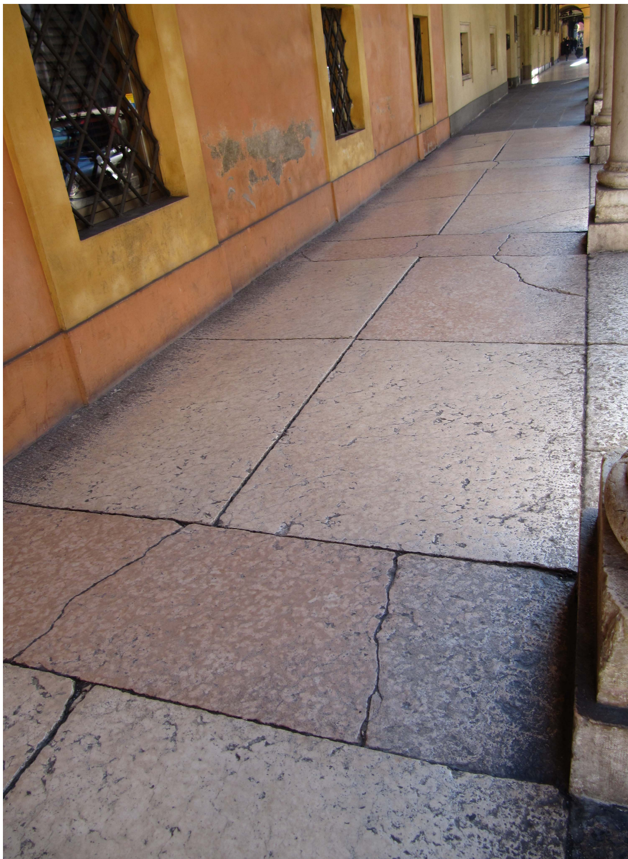
Portico del Palazzo Caroli Cesis del sec. XVIII, in Corso Canalgrande. Lastre in "rosa ammonitico veronese". Disposizione delle lastre e contrapposizione di effetti cromatici.
