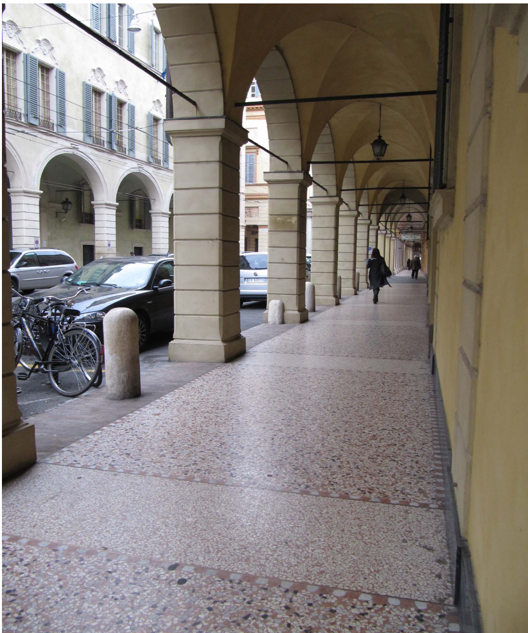
PARTICOLARE 9 - PORTICO DI CORSO CANALGRANDE ( ORA RISTRUTTURATO ) TRATTO COMPRESO FRA VIA DELLE CARMELITANE SCALZE E VIA S. GIOVANNI DEL CANTONE Si noti l'inserimento dei fittoni in marmo di Verona all'interno dell'ammattionato fra i pilastri del portico.
