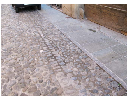
Evidenziazione degli elementi strutturanti il selciato
