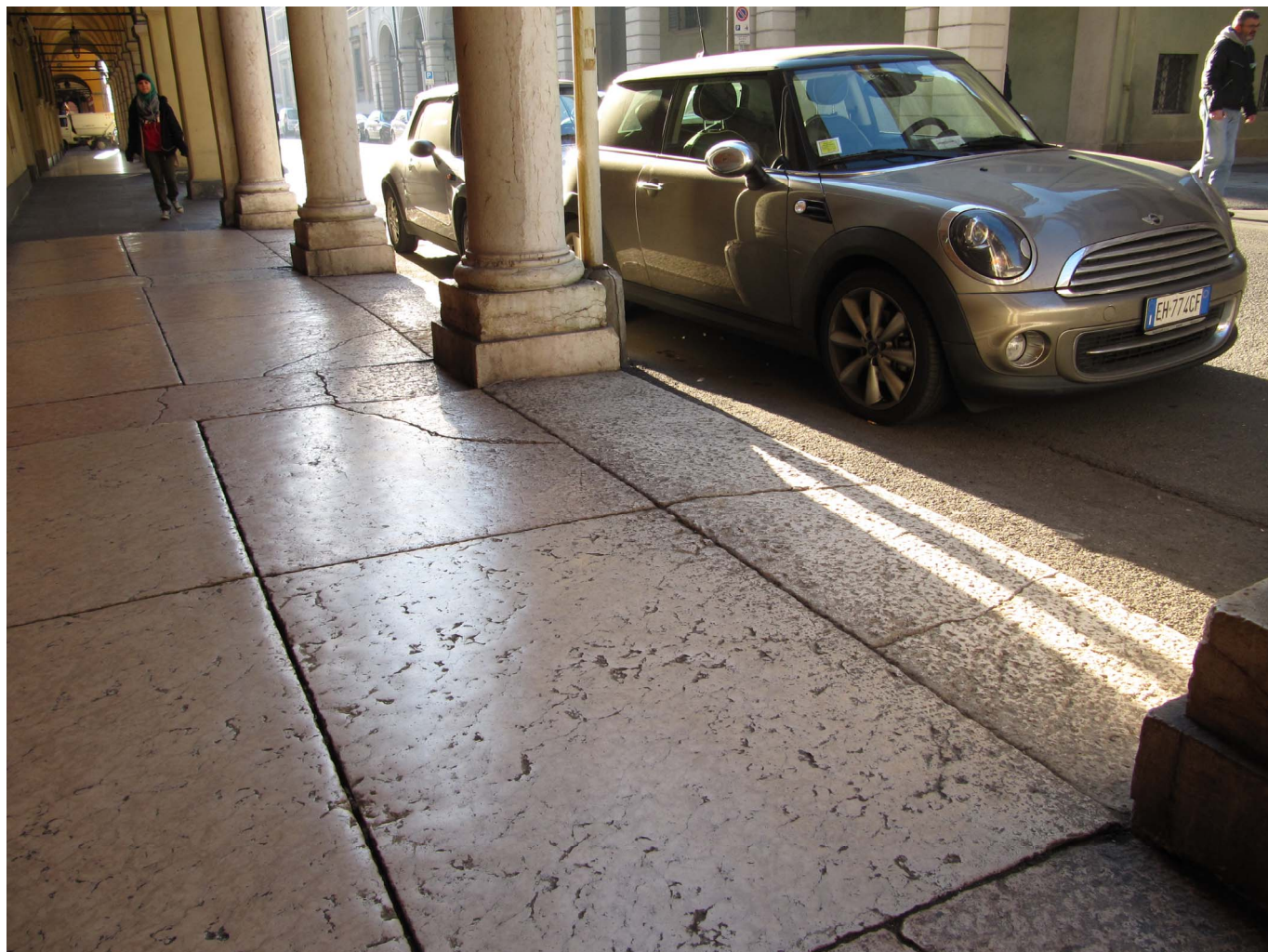
Portico del Palazzo Caroli Cesis del sec. XVIII, in Corso Canalgrande. Spazio intercolonnare trattato rendendo "scabra" la superficie delle lastre: antigelivo e antisdruciolo, ottenuto con la bocciardatura della superficie.
