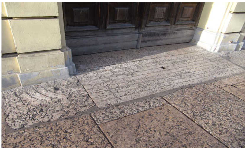
Particolare della "graffiatura" delle lastre in una soglia di Corso Vittorio Emanuele II, per ridurre la la sdruciolevolezza della superficie .
