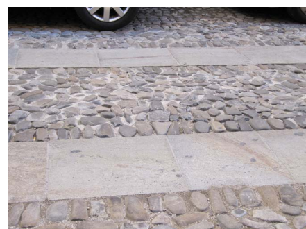
Evidenziazione degli elementi strutturanti il selciato
