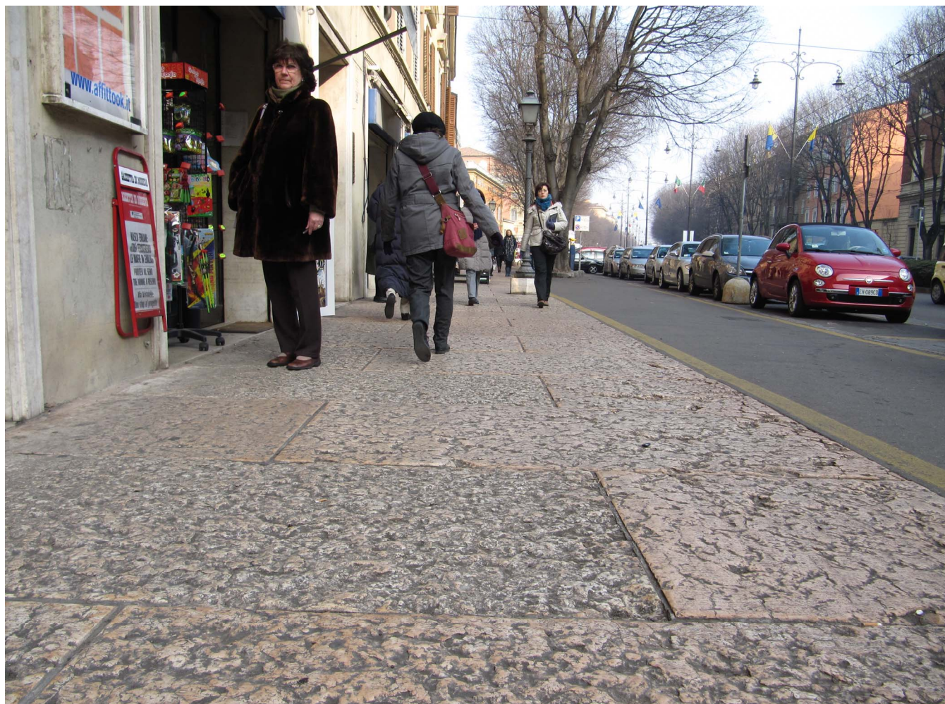
Percorso pedonale di Viale Vittorio Emanuele II Particolare della "superficie scabra" con bocciardatura delle laste, posate con ampie fughe .
