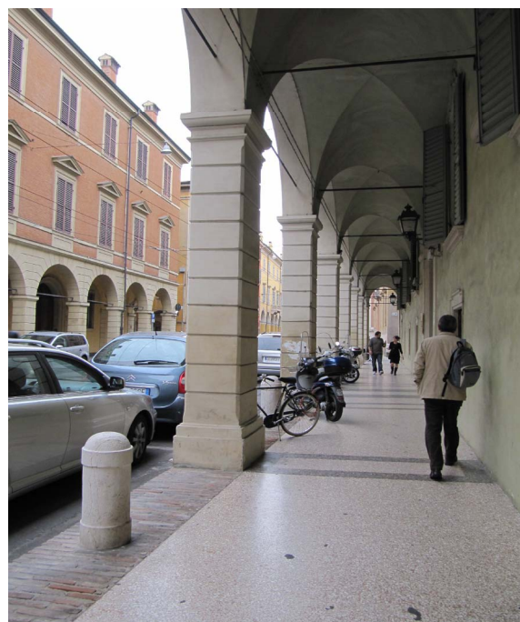
Esempio di fittone nello spazio intercolonnare del portico
