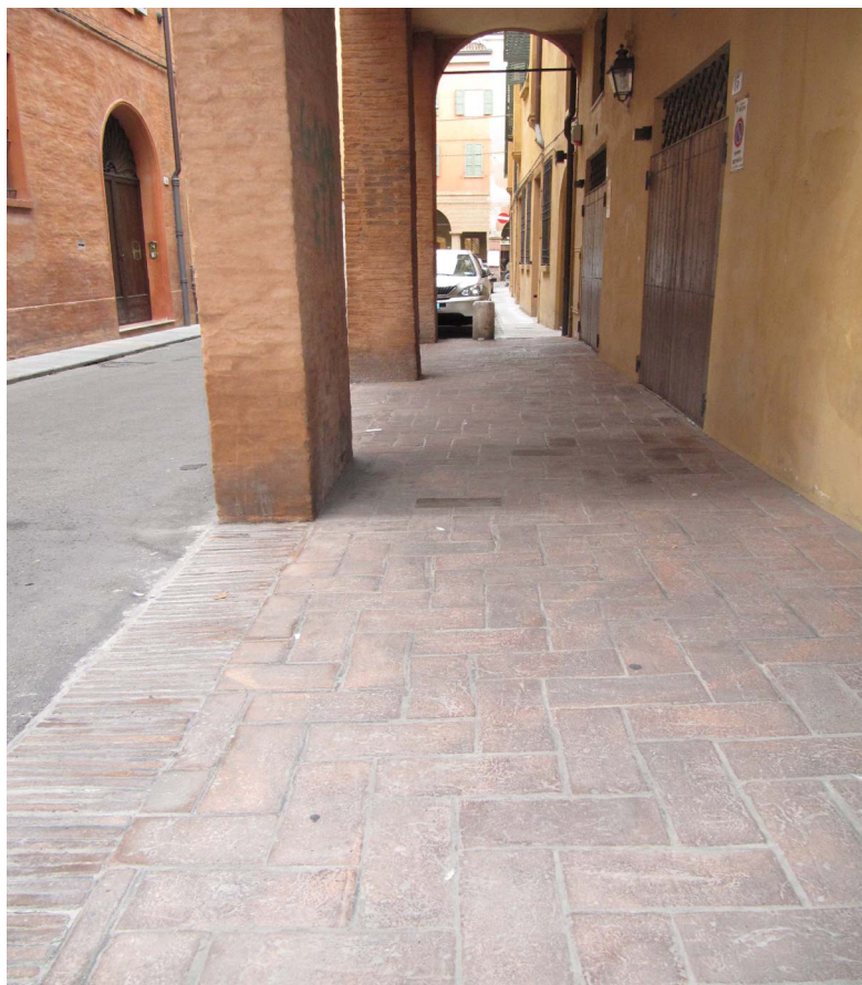
PORTICO DI VIA BONACORSA – AMMATTONATO IN TAVELLE (ORA RISTRUTTURATO)
