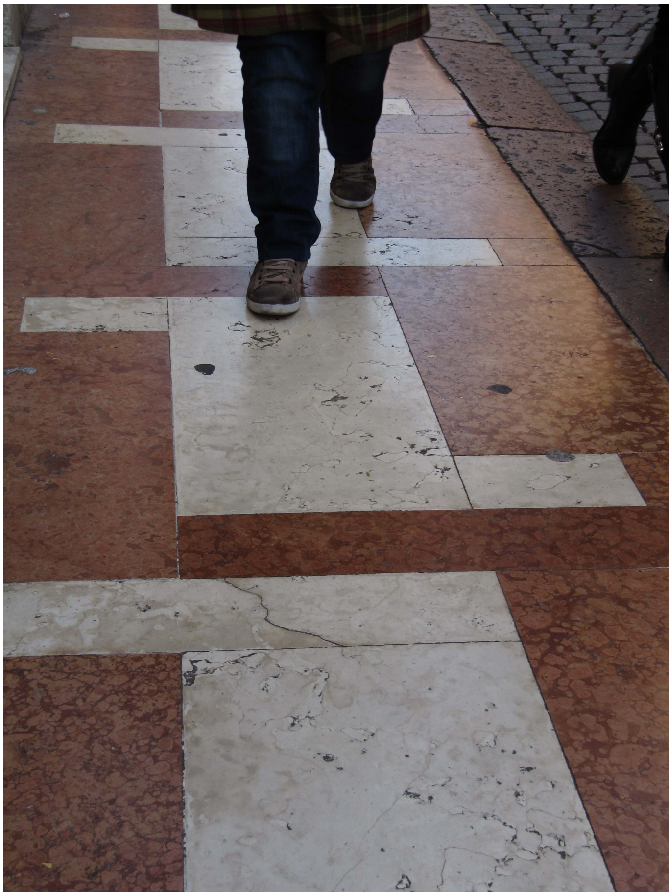
VIA EMILIA ANGOLO VIA S. CARLO - Disposizione delle lastre e contrapposizione di effetti cromatici IL "BIANCONE" AL CENTRO E "IL ROSSO" ALL'ESTERNO, PERCHE' SONO MENO GELIVI DEL TIPO "ROSA".
