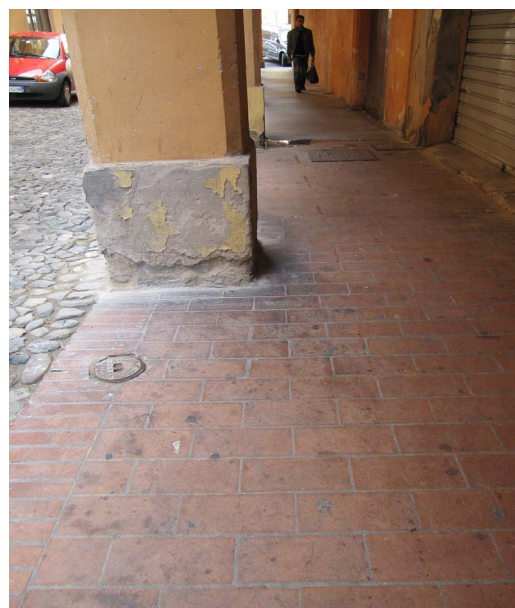
PARTICOLARE 1 – MATTONI POSATI "DI COSTA" (TIPICA POSA SETTECENTESCA) E PARTE TERMINALE, POSATI "DI COLTELLO" IN ATTESTAZIONE ALL'ACCIOTTOLATO
