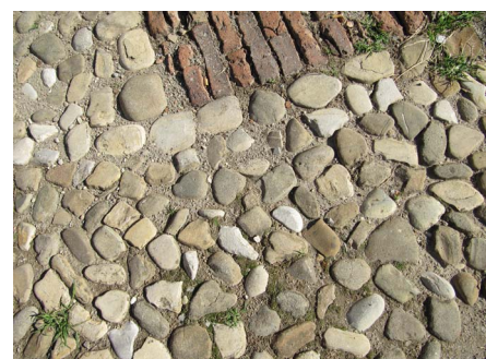
I FITTONI IN ARENARIA AMMATTONATO CON POSA A SPINA DI PESCE
