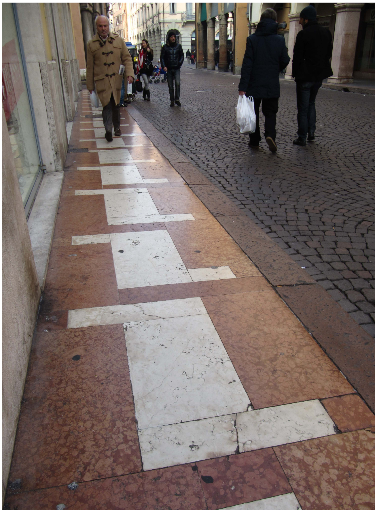
VIA EMILIA ANGOLO VIA S. CARLO - Disposizione delle lastre e contrapposizione di effetti cromatici. LASTRE DI "ROSSO e BIANCO AMMONITICO VERONESE" (nel 1979 sono state sostituite le lastre precedenti).
