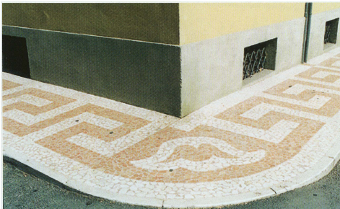
PARTICOLARE 2 – MARCIAPIEDE ALL'ANGOLO FRA VIA GANACETO E CORSO CAVOUR
