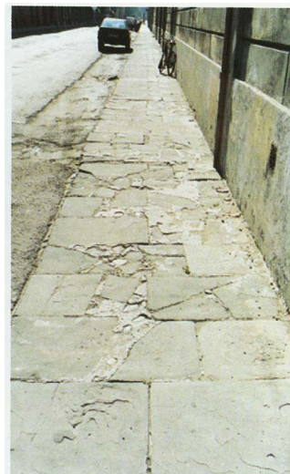
PARTICOLARE 3 MARCIPIEDE IN LASTRE DANNEGGIATE
