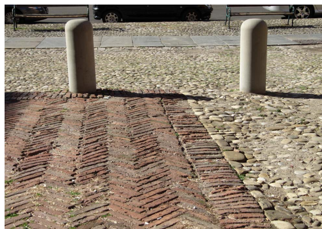
I FITTONI IN ARENARIA AMMATTONATO CON POSA A SPINA DI PESCE
