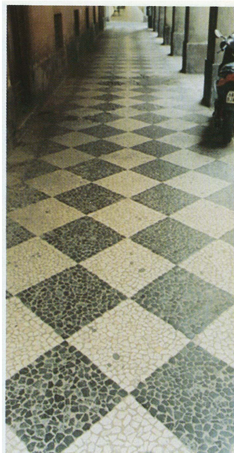
PARTICOLARE 5 VIA FONTERASO BATTUTO ALLA VENEZIANA NEL PORTICO
