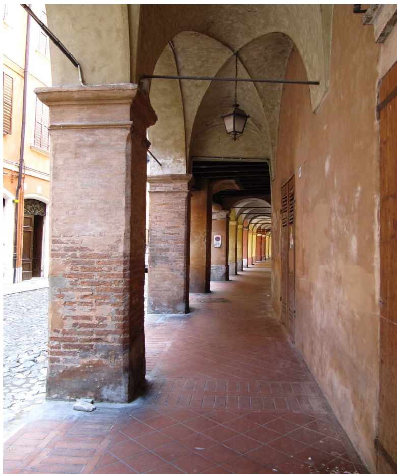
PORTICO DI VIA TRE RE – AMMATTONATO CON MATTONI A FORMA QUADRATA (ORA RISTRUTTURATO)
