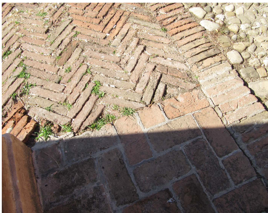
LATO NORD DELLA CHIESA - L'AMMATTONATO TRADIZIONALE: CON DUE TIPI DI POSA E L'ACCOSTAMENTO AL SELCIATO IN ACCIOTTOLATO
