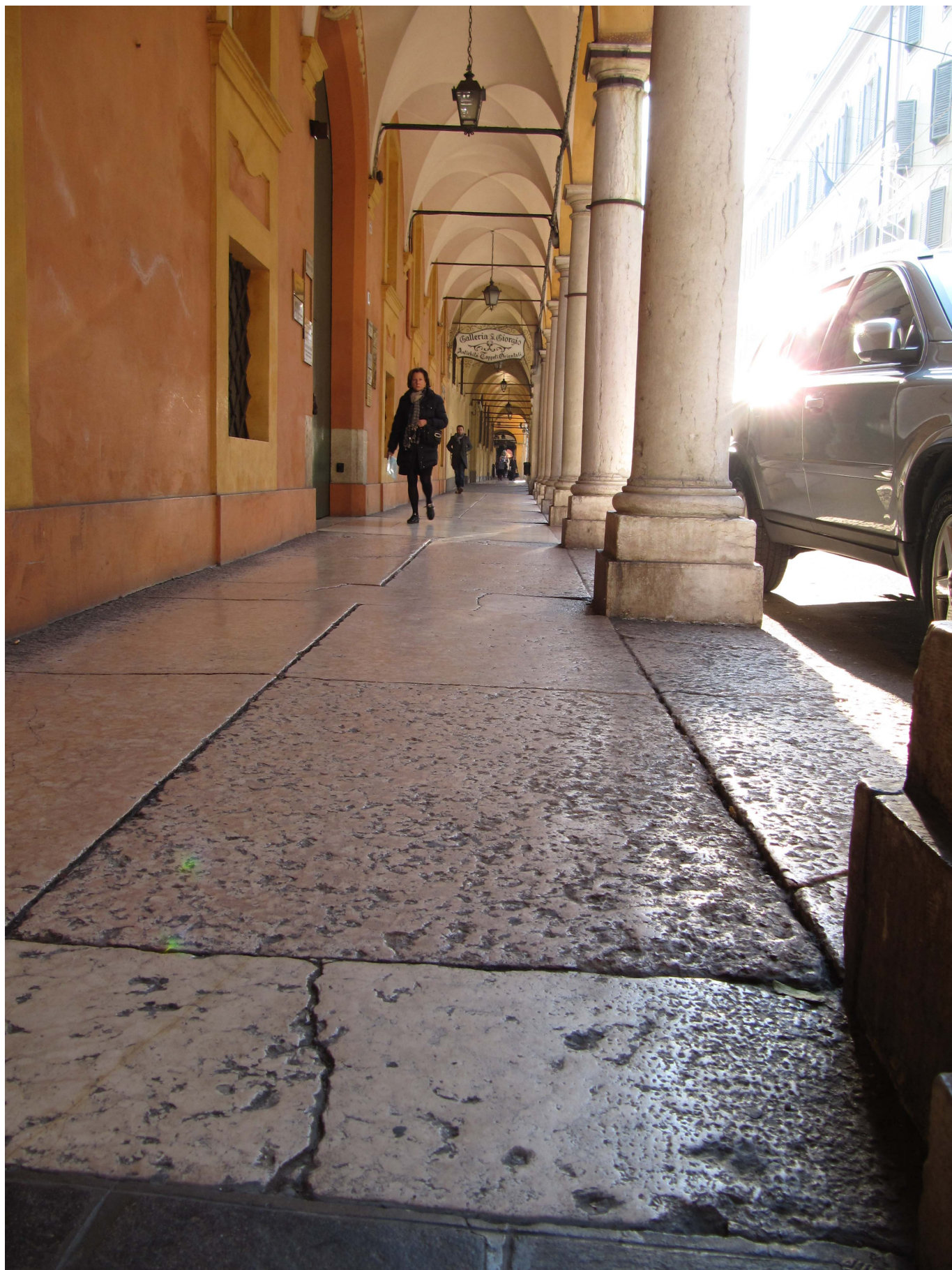
Particolare delle lastre di "rosa ammonitico veronese" nel portico del Palazzo Caroli Cesis del sec. XVIII, in Corso Canalgrande.
