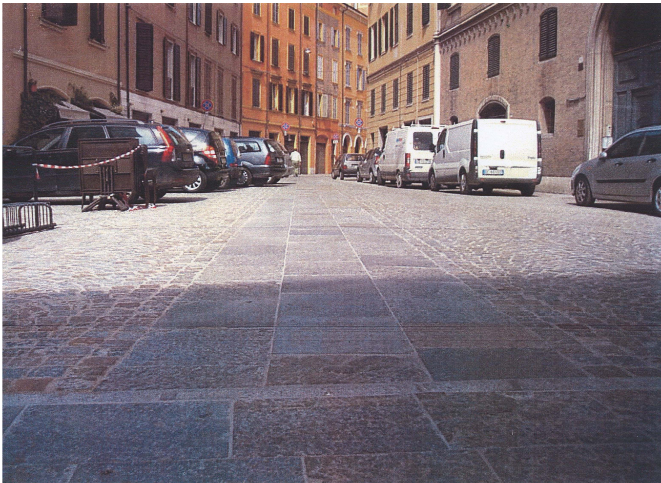
PARTICOLARE 1 – PIAZZALE TORTI (RECENTEMENTE RISTRUTTURATO) - IL LASTRICATO E' FORMATO DA LASTRE DI VARIE PEZZATURE
