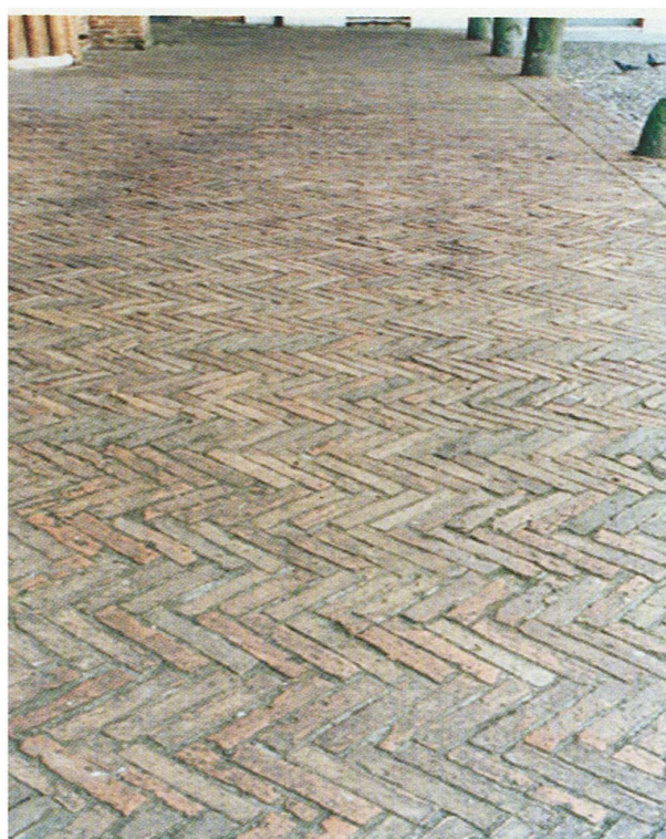
MATTONI POSATI "DI COLTELLO" ED ORDITURA A "SPINA DI PESCE"
