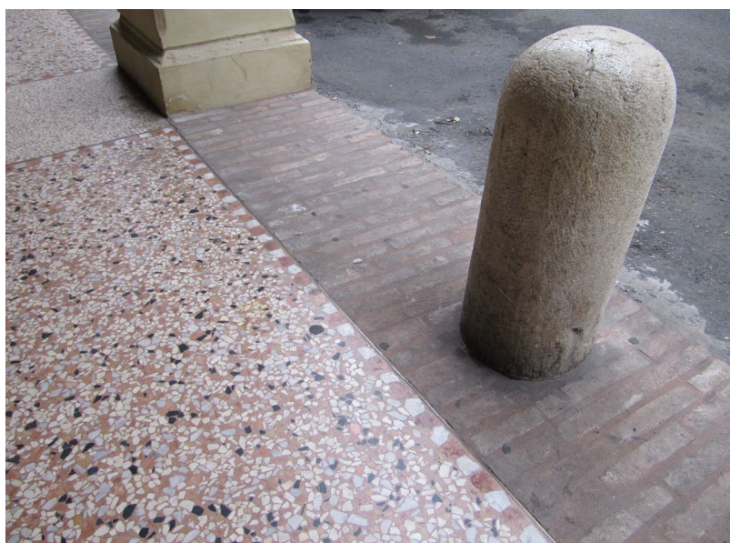
PARTICOLARE 9 - PORTICO DI CORSO CANALGRANDE ( ORA RISTRUTTURATO ) TRATTO COMPRESO FRA VIA DELLE CARMELITANE SCALZE E VIA S. GIOVANNI DEL CANTONE Si noti l'inserimento dei fittoni in marmo di Verona all'interno dell'ammattionato fra i pilastri del portico.
