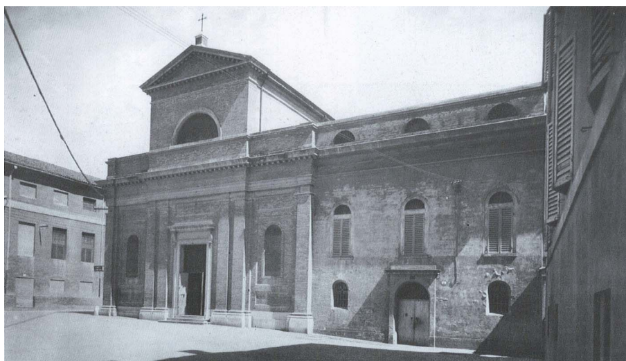
VIA SAN GIOVANNI DEL CANTONE - INIZI DEL '900. La facciata della Chiesa di San Giovanni del Cantone con l'annesso Convento. Oggi al loro posto c'è un fabbricato moderno, sede degli uffici dell'Unità Sanitaria Locale.
