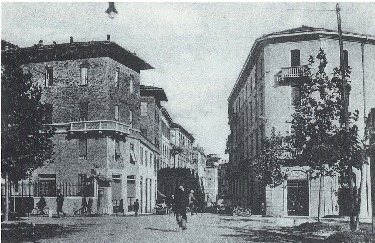
CALLE DI LUCA – Vista dalla Via Giardini, all'altezza di Piazzale Risorgimento. Anno 1930.
