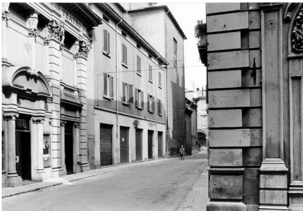
VIA GHERARDA – Vista in direzione di Corso Canalgrande. Fotografia di Paolo Monti, anno 1973.
