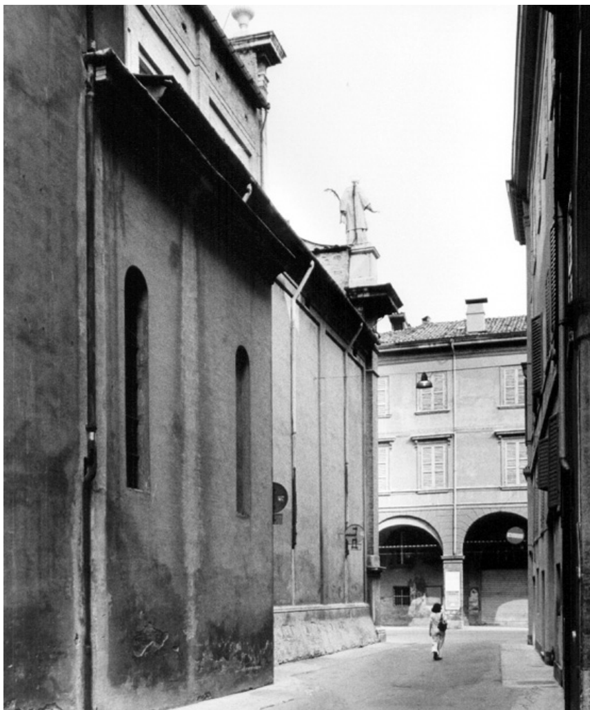
VIA GHERARDA – Vista in direzione di Corso Canalgrande. Fotografia di Paolo Monti, anno 1973.
