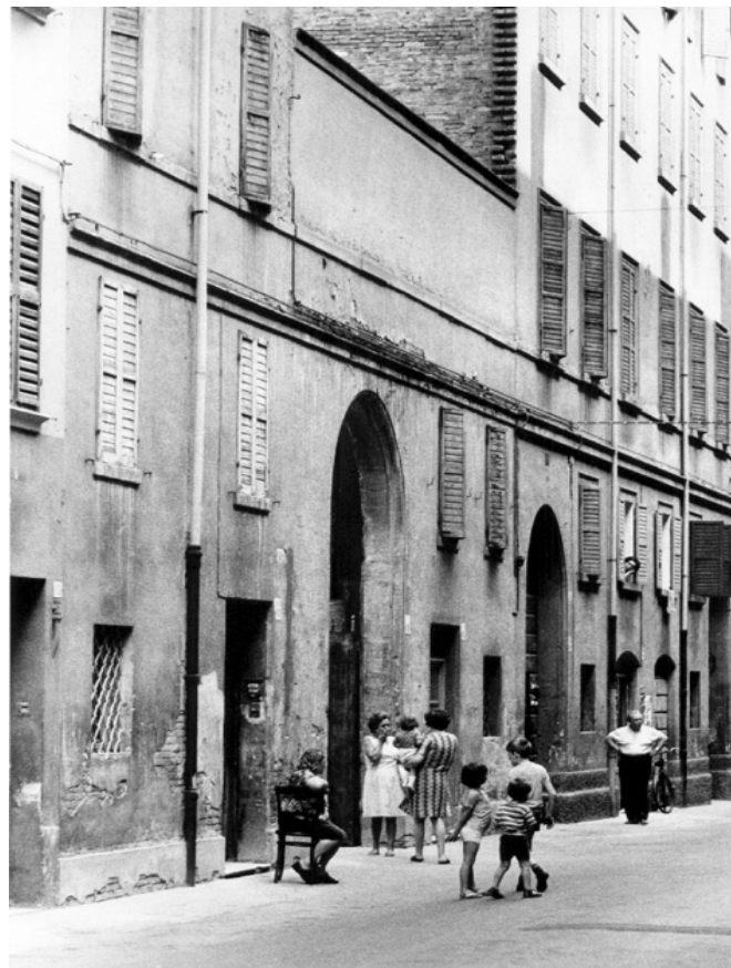
RUA PIOPPA - Vista di Rua Pioppa dall'intersezione con Vicolo del Cane.
