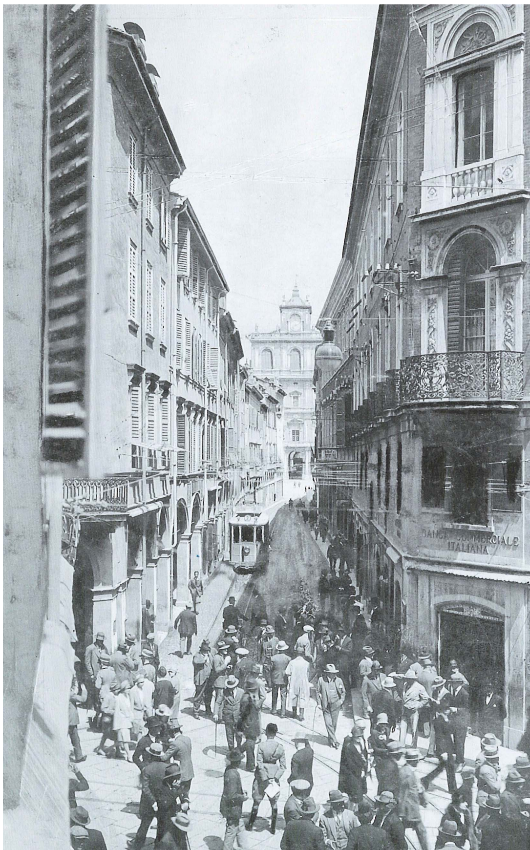
VIA FARINI. Fotografia c.a 1925 (Collezione Tonini, inv. pos 10493), presso la Biblioteca Poletti di Modena. Particolare della "lampada a sospensione" posta per l'illuminazione a centro strada (al centro immagine).
