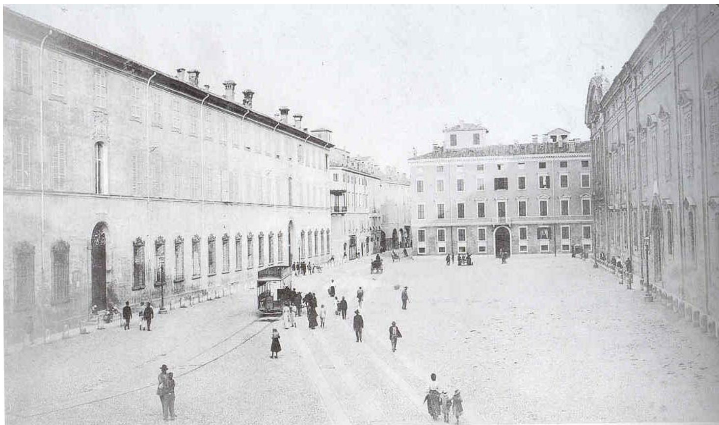
LARGO PORTA S. AGOSTINO o Piazza Sant'Agostino nella fotografia del 1905 – 1910 ( Fotografia Alfredo Giuliani). Collezione Tonini, inv. pos 33, presso la Biblioteca Poletti di Modena. Particolare del "palo con lanterna a candelabro, con sottopalo in marmo" di illuminazione della piazza.
