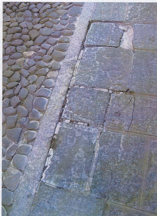
21/03/2012. Particolare del selciato in acciottolato e marciapiede in lastre di gneiss.
