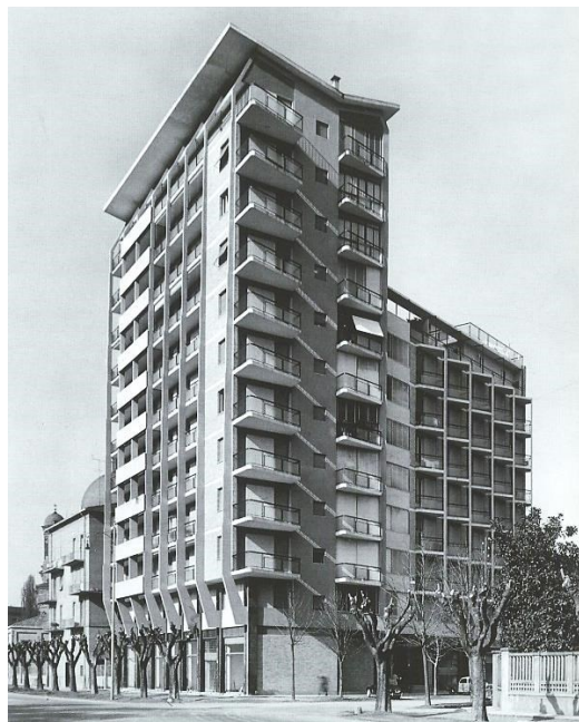
Figura 114. Il Condominio a torre (negozi al piano terra e residenza nei successivi): progetto di Vinicio Vecchi. La torre è sul viale Caduti in Guerra, in direzione dei Giardini Ducali Estensi (*).
