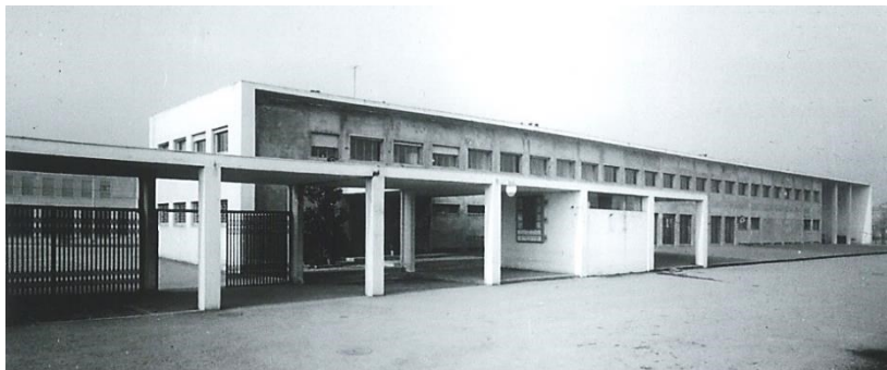
Figura 117. La palazzina per uffici e servizi all'ingresso del (ex) Mercato bestiame nel 1951: progetto di Mario Pucci come assessore e capo-ufficio tecnico LLPP. Il portico retrostante verrà demolito per effetto del Piano di riqualificazione comunale negli anni '90.
