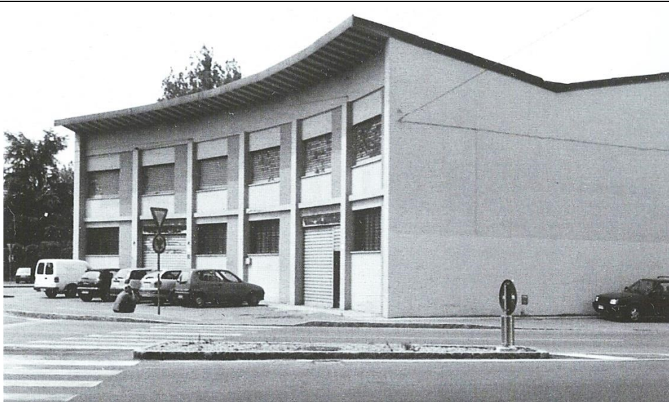
Figura 112. La Casa-Officina su viale Monte Kosica, progettata e realizzata da Ugo Cavazzuti (all'interno di un ampio Piano-progetto del Quartiere degli Sport, redatto dal Comune: Mario Pucci come assessore e capo-ufficio Tecnico).
