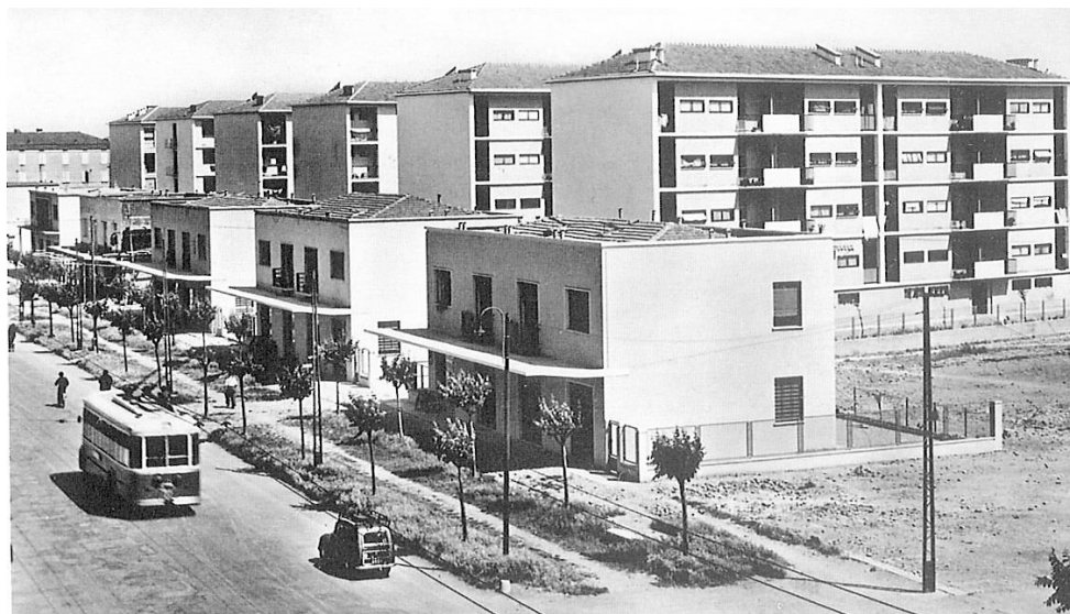
Figura 109. Quartiere progettato dal Comune (Mario Pucci come assessore e capo-ufficio Tecnico) per INA Casa, con la collaborazione di Vinicio Vecchi (*).
