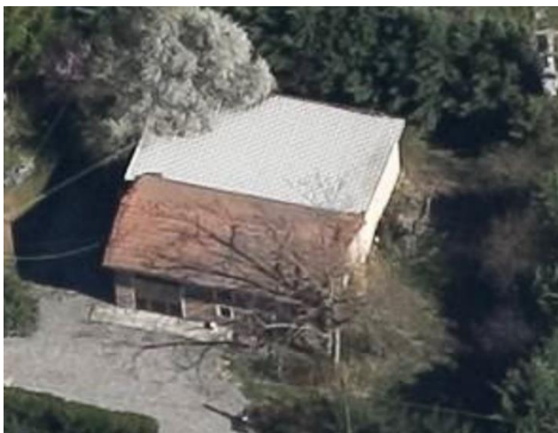
Figura 16 - CODEDIF 4607. Edificio con ampliamento in distonia materica.
