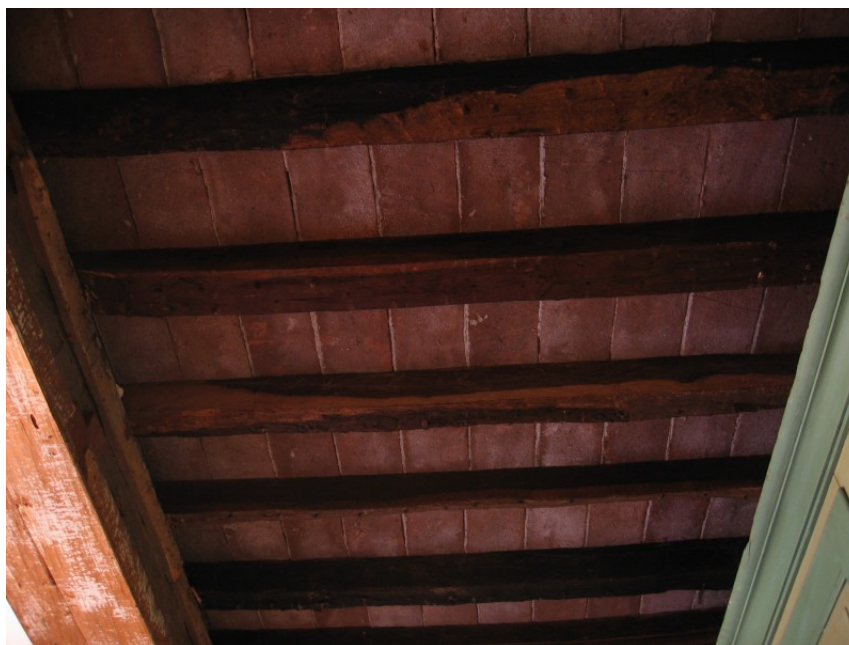
Foto 1 – Solaio della “Sala dei Confratelli”
