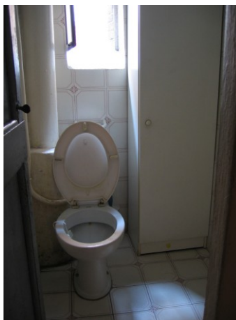
Foto 2 – I servizi igienici oggetto di rifacimento
