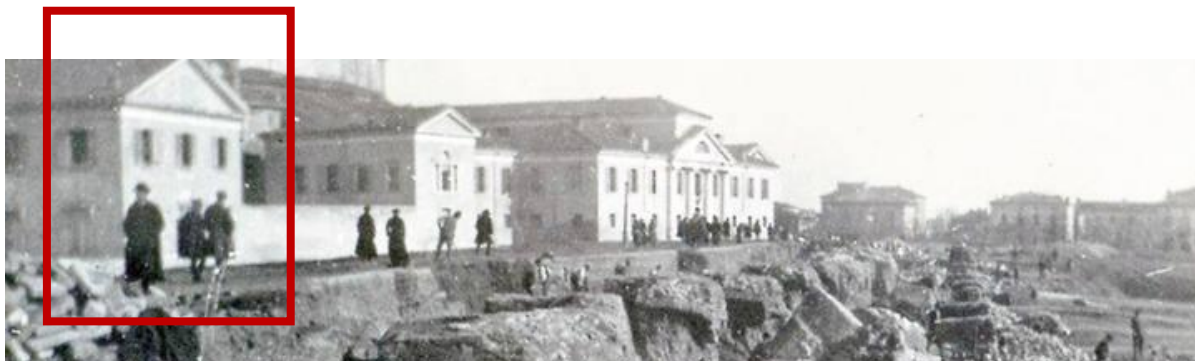
Foto 14 – demolizione delle mura. In questa immagine è chiaramente visibile l'assenza dell'apertura circolare nel timpano Ovest.
