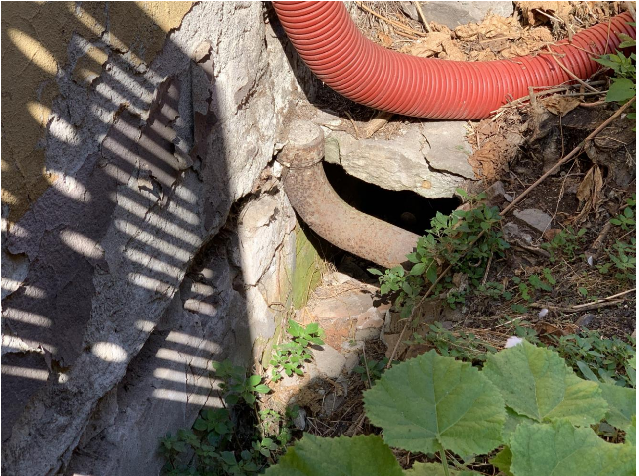
Img 04_ stato attuale. Scannafosso esistente parzialmente distrutto o danneggiato
