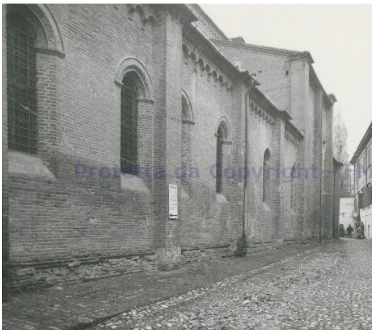
Foto 18 – è chiaramente visibile l'originaria pavimentazione in ciottoli di fiume
