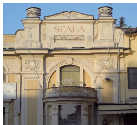
Cinema "Scala", particolare dell'ingresso.
