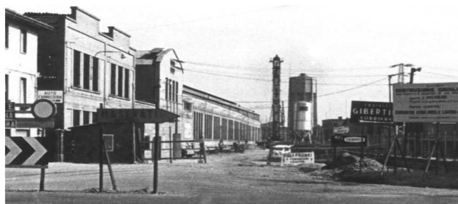
Cavalcavia Crocetta in costruzione.
