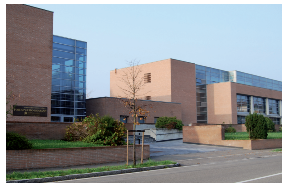
Vista del prospetto laterale.
