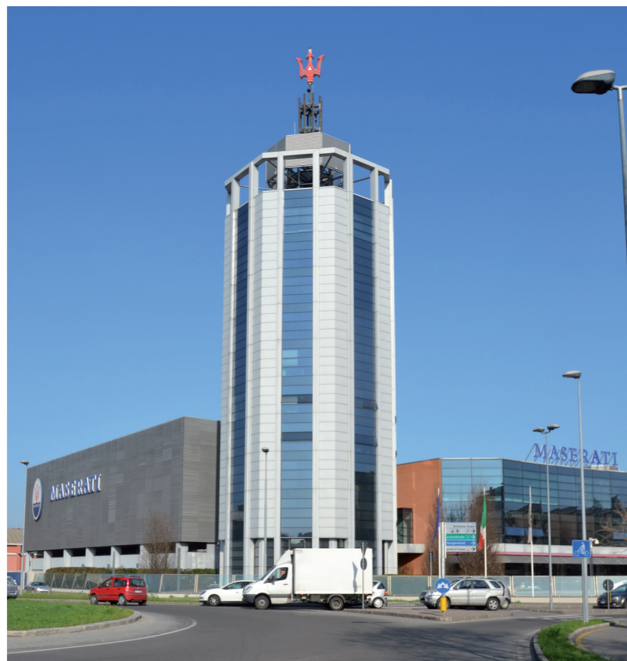
Vista della torre degli uffici da via Ciro Menotti.
