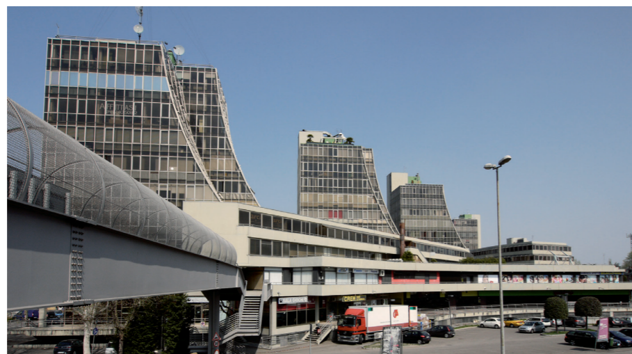
Vista del complesso da via Giardini.
