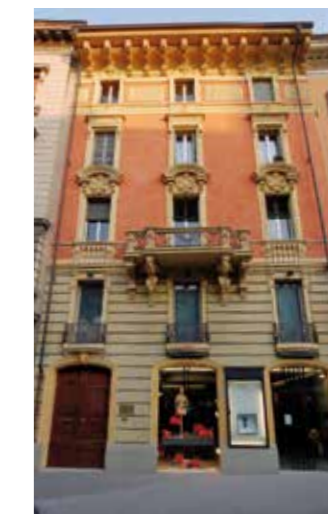
Particolare del fronte est della Piazza.
