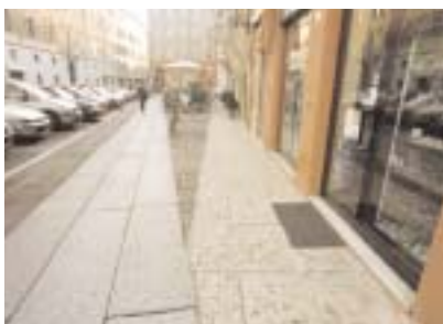
Alcuni dei marciapiedi recuperati nel centro storico cittadino grazie ai contributi del Comune
