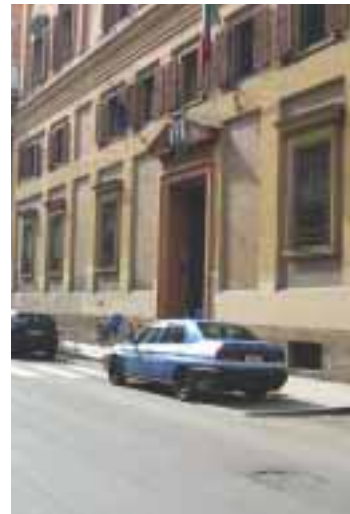
A lavori ultimati, negli uffici di corso Canalgrande 77 saranno sistemate e riaccorpate tutte le funzioni del tribunale.
