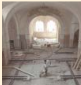
Il cantiere a palazzo Santa Margherita
