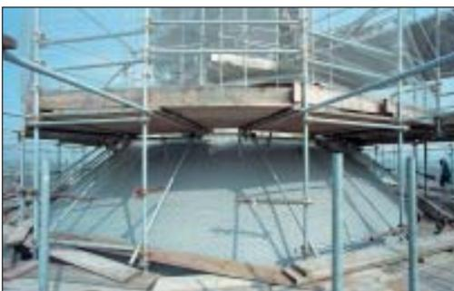
crocefisso e li ha posati a terra. Qui sono stati sottoposti a restauro: nuova doratura per il globo e recupero delle parti in ferro del crocefisso. Più lenta del previsto la fornitura delle scandole (tegole) nuove in cemento e cellulosa, costruite secondo il modello originale degli anni venti da un'azienda austriaca. Ma
