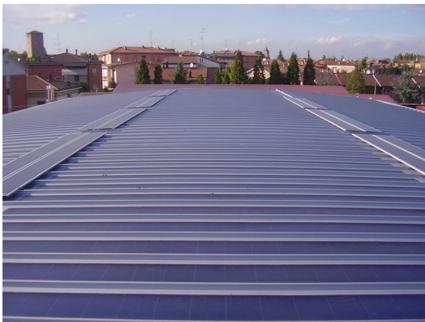
Palestra di Nonantola - Cella a film sottile - Potenza: 40-65 Wp/m 2
